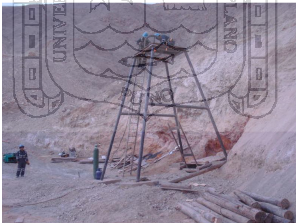
Foto: Instalación del castillo.
