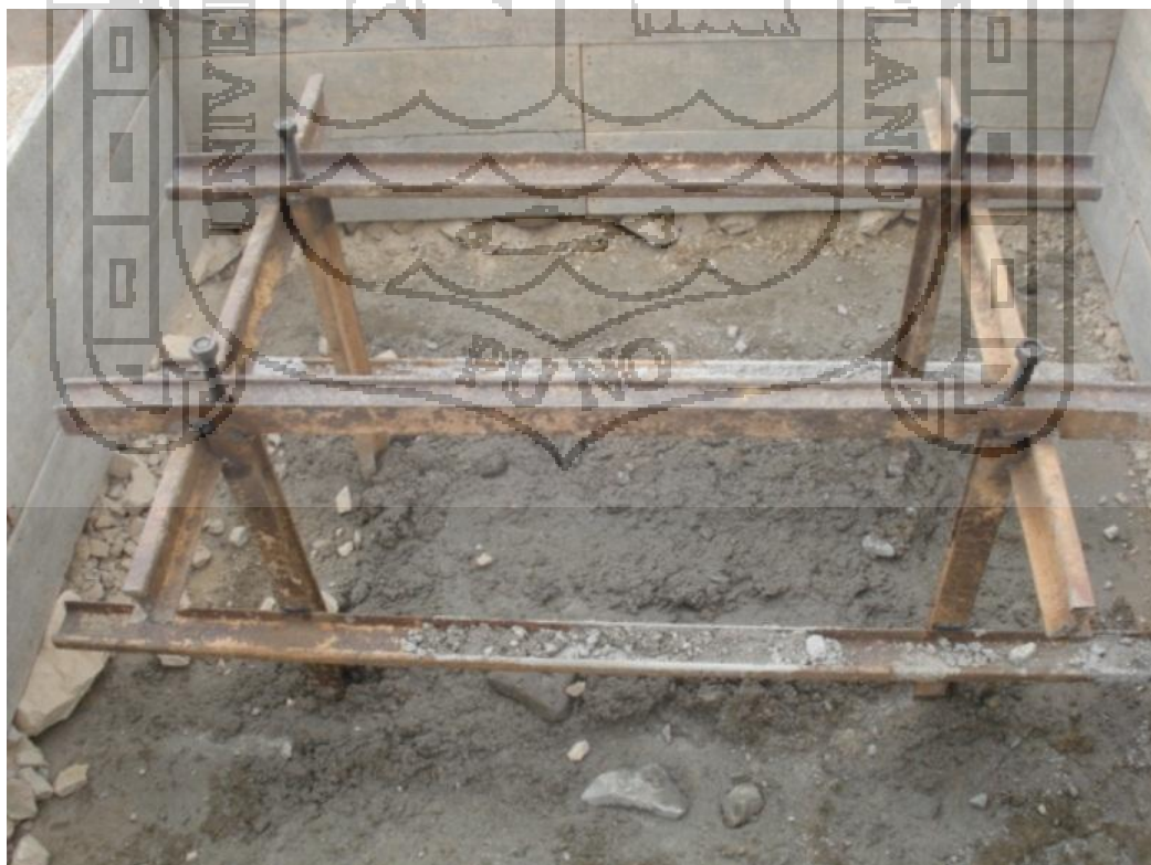
Foto: Estructura metálica (Base para anclar el winche)
