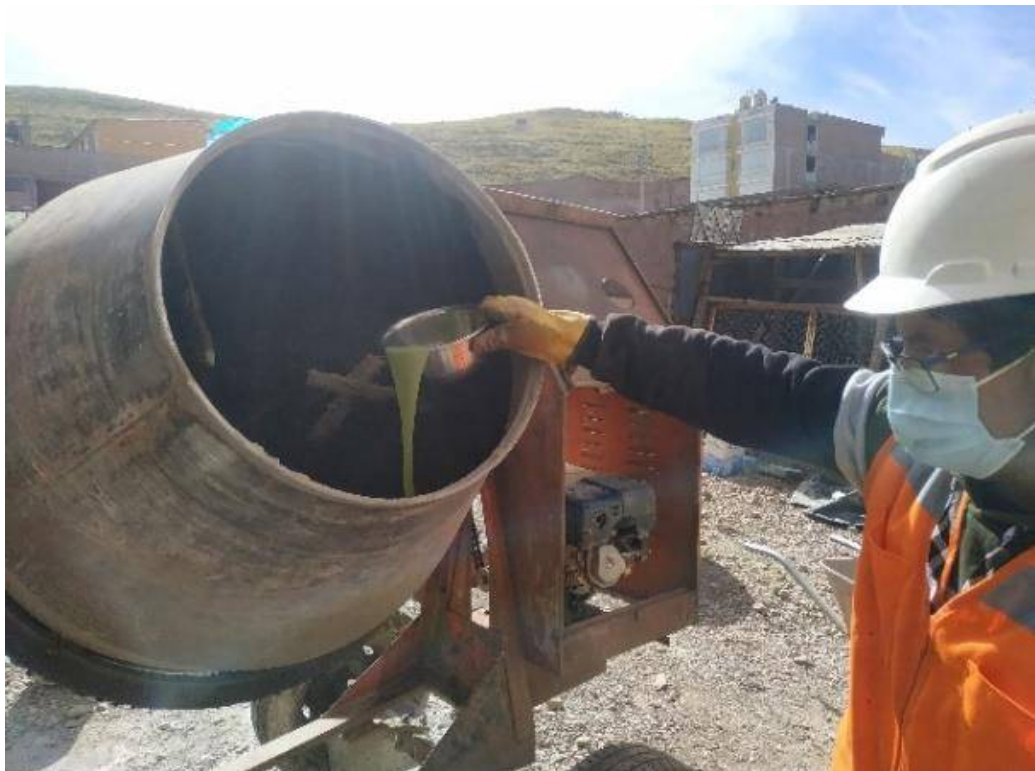
Ilustración 12. Adición de MC natural a la mezcla
