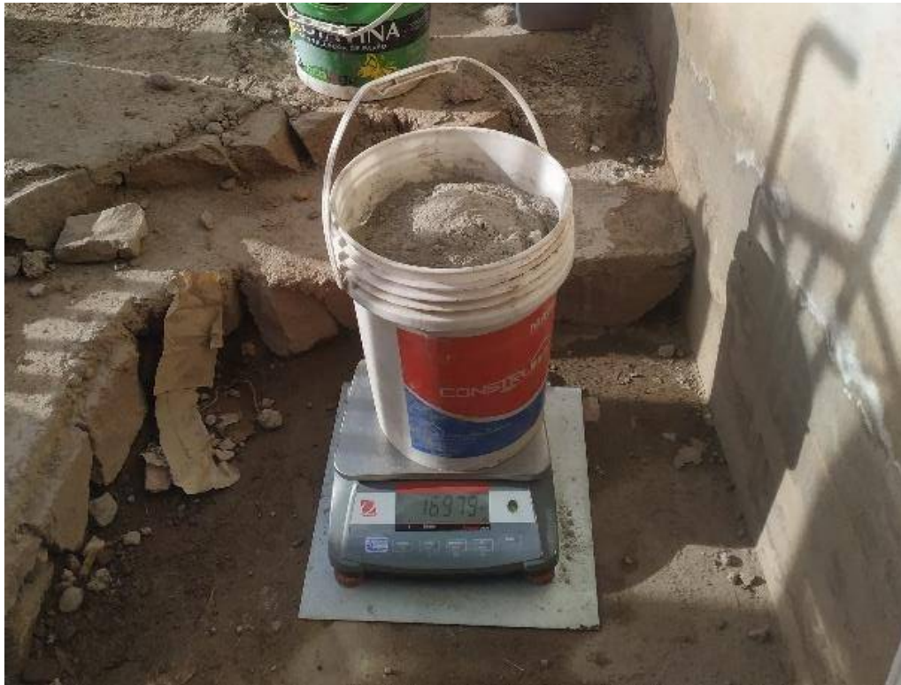
Ilustración 9. pesado de cemento
