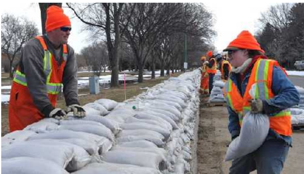
FIGURA 4-9 DEFENSA RIBEREÑA CON SACOS RELLENOS
