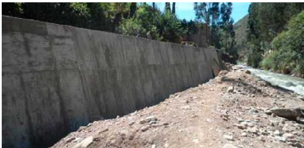
FIGURA 4-6 MUROS DE CONCRETO CICLÓPEO [REGIONPASCO.GOB.PE]
