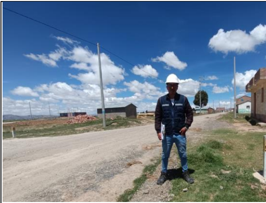
Foto 09: Km 03+000.00, tipo de superficie de rodadura de afirmado, estado de transitabilidad regular, tipo de terreno plano.
