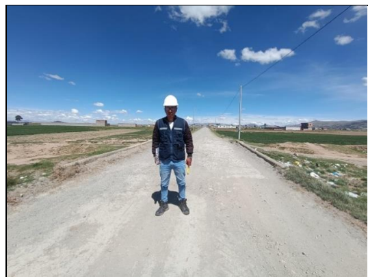
Foto 06: Km 01+295.00, Se observa la via con el tipo de superficie plana y tiene una transitabilidad regular a buena.
