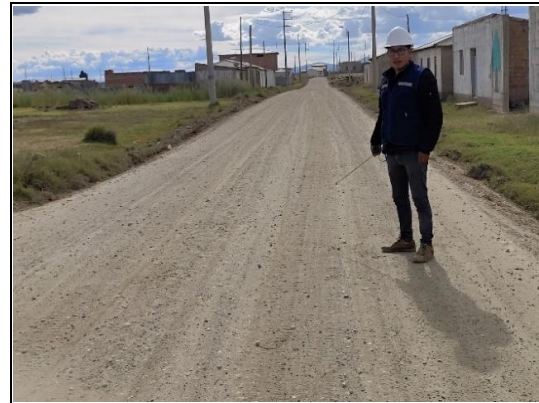
Foto 08: Km 2+000.00 - km 2+ 500.00, Se observa el tipo de superficie de rodadura de afirmado, estado de transitabilidad regular con el tipo de superficie plana.
