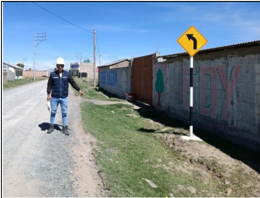
Foto 21: Km 0+692.88, Señal Preventiva al lado izquierdo de la vía, poste de soporte de fierro con dobles en la parte inferior del poste.
