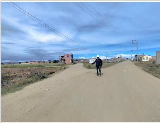
Foto 01: Km 00 + 592.10, Se observa el desvío para la comunidad de Tuni Grande.
