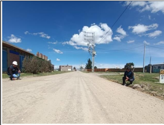
Foto 07: Km 2+000.00, Se observa el tipo de superficie plano, estado de transitabilidad regular, se observa la medición del ancho de superficie de
