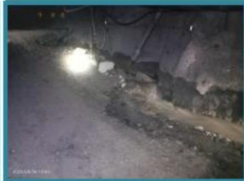
Imagen 07 y 08: Se evidencia con imágenes la fuga de agua de la cuneta por el exceso de caudal que llega a dicho punto.
