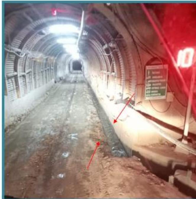
Imagen 01 y 02: Ingreso Bocamina 4300, se evidencia huellas de neumáticos que transitan cerca de las cunetas sin protección.
