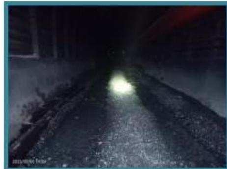
Imagen 09 y 10: Se evidencia acumulación de agua en la vía y agua escurriendo por la vía, generando desgaste y condiciones para equipo que transitan por la zona.
