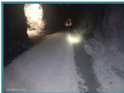
Imagen 11: En el nivel 4165 se tiene la vía inclinada hacia el hastial
