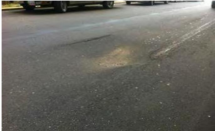
Nota: La imagen nos muestra el tipo de falla, abultamientos y hundimientos. Tomado de: *Cálculo del índice de condición del pavimento flexible a la Av. Don Bosco - Piura usando drones* (p. 22), por C. D. Fiestas, F. G. Merino, 2020, (<https://alicia.concytec.gob.pe>).
