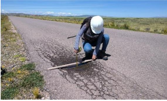
Medición de fallas en el eje z
