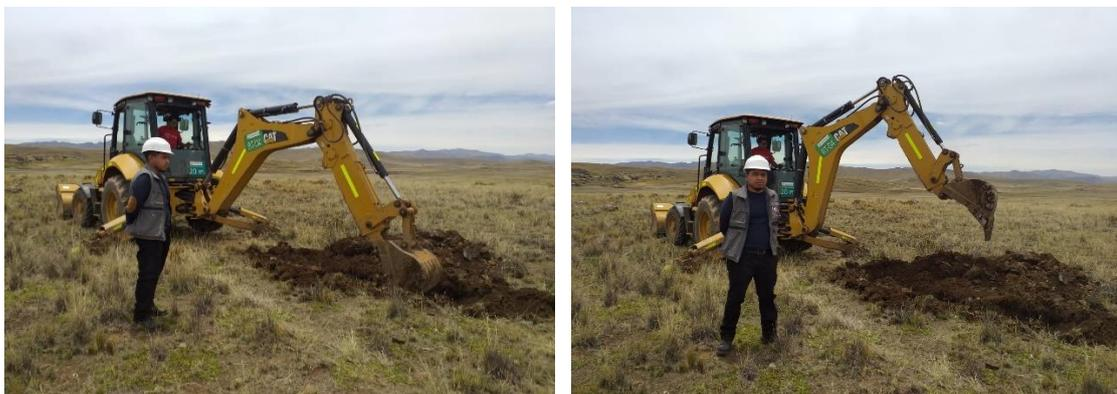
Nota: Se observa a la retroexcavadora realizando la excavación de calicatas en los puntos correspondientes.
