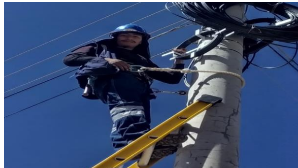
Instalación de reserva de fibra óptica
