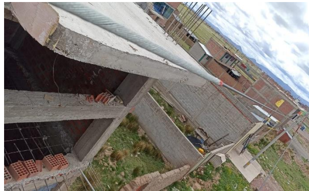
Preformado de la Fibra Óptica en el Poste
