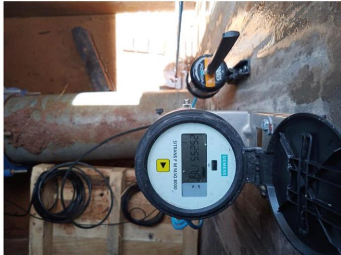
Nota: La imagen muestra el Transmisor marca SIEMENS Modelo MAG8000 y marca valores en  $m^3$  y lt/s. Ver Anexo 6.
