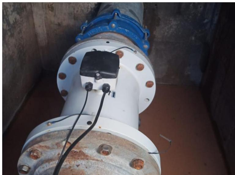
Nota: La imagen muestra el sensor marca SIEMENS Modelo MAG8000 IP68 el cual está instalado en la tubería. Ver Anexo 6.
