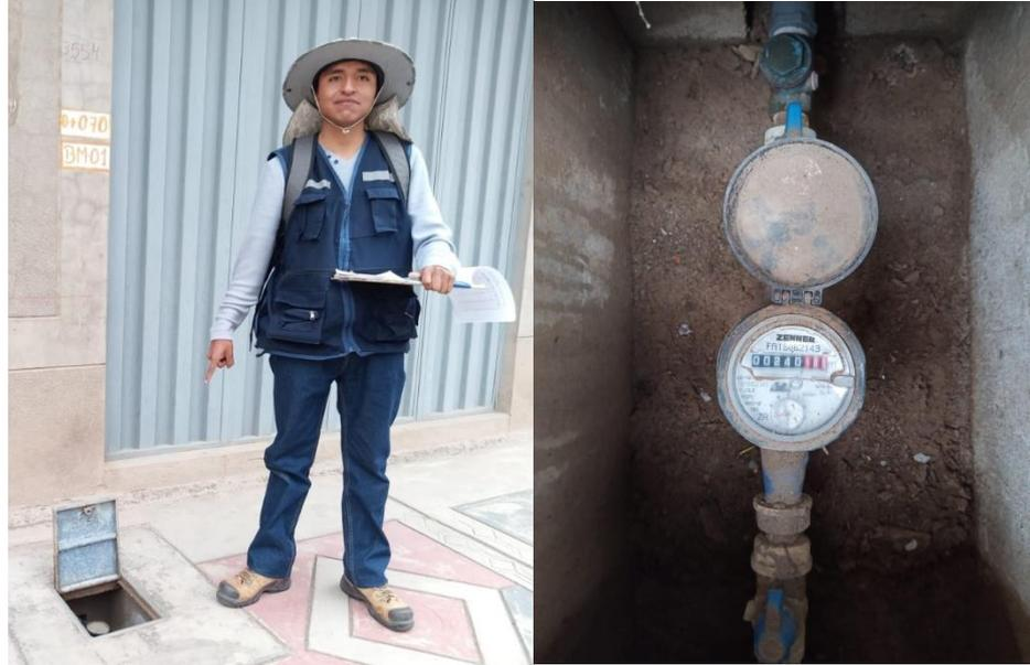
Nota: En la figura se muestra el registro de lectura del micromedidor en la conexión domiciliaria identificada con el código 3554.
