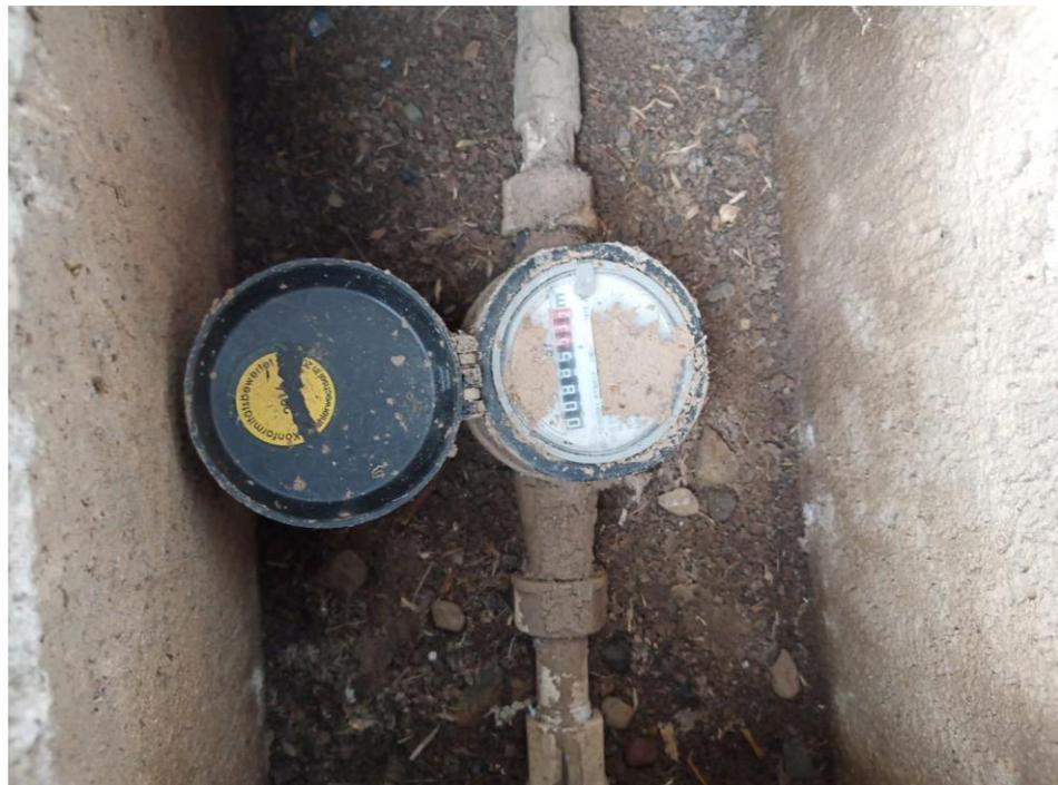
Nota: En la imagen se muestra un micromedidor instalado en una conexión domiciliaria.
