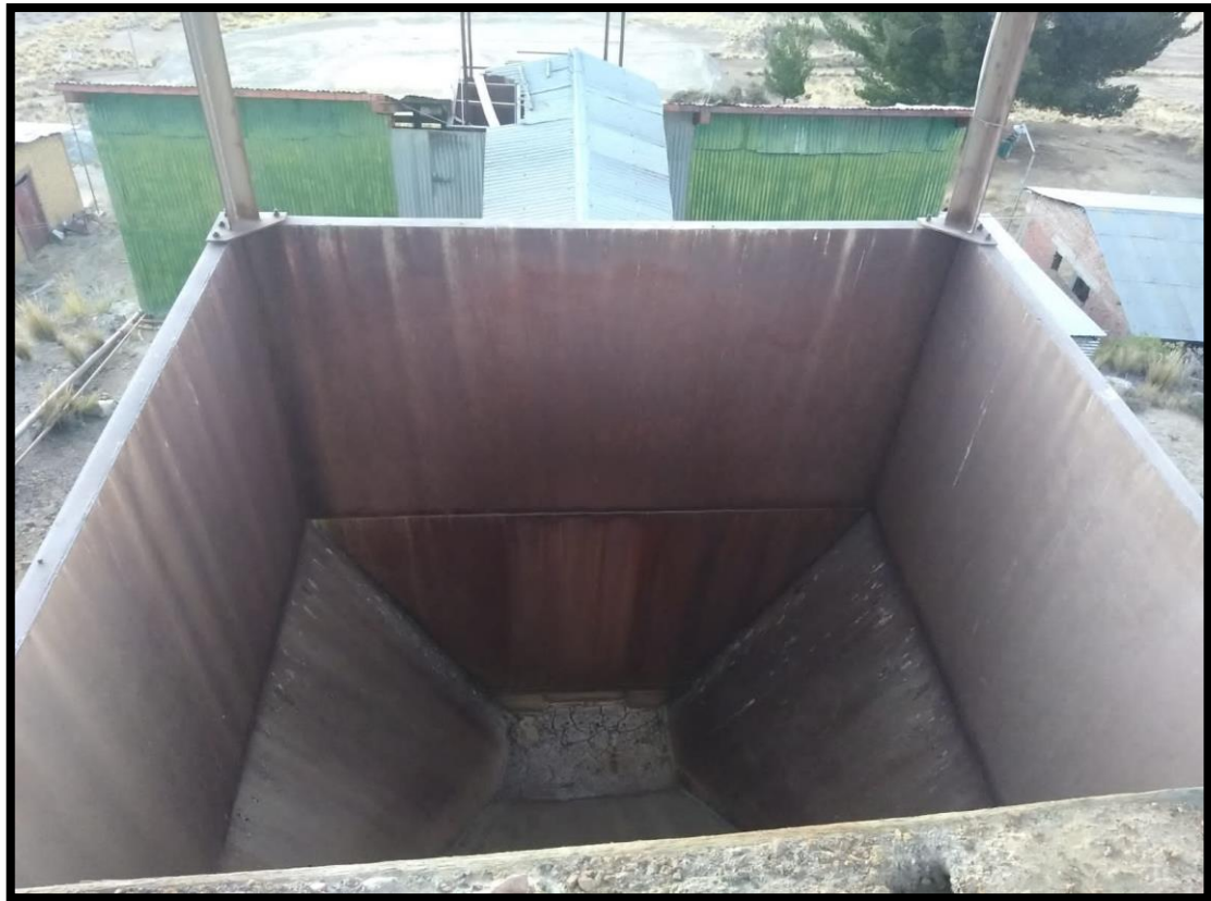
Figura A.3. Tolva de gruesos de la planta concentradora de Tiquillaca
