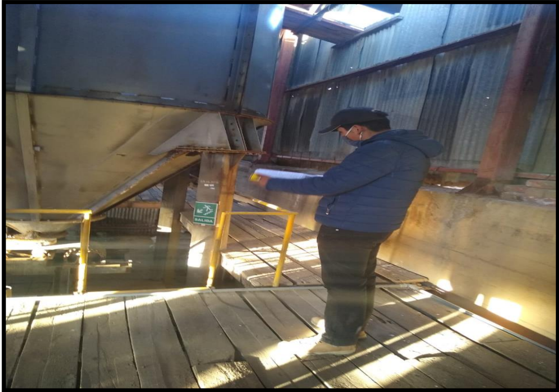
Figura A.17. Evaluación de la operación de la tolva de finos
