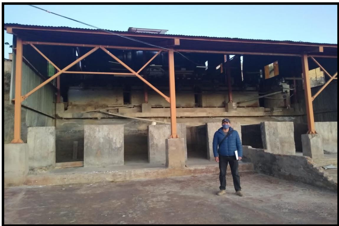
Figura A.4. Inspección de la planta concentradora de Tiquillaca
