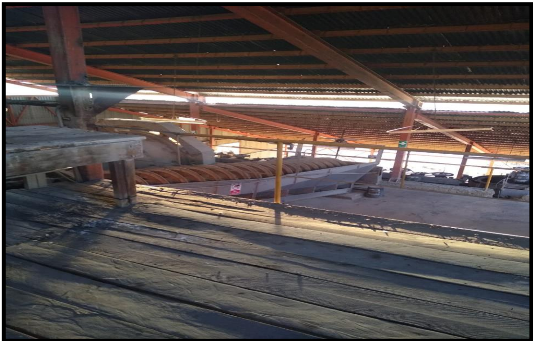
Figura A.14. Área señalizada de la planta concentradora de Tiquillaca
