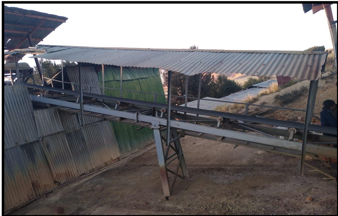
Figura A.10. Faja transportadora de la planta concentradora de Tiquillaca
