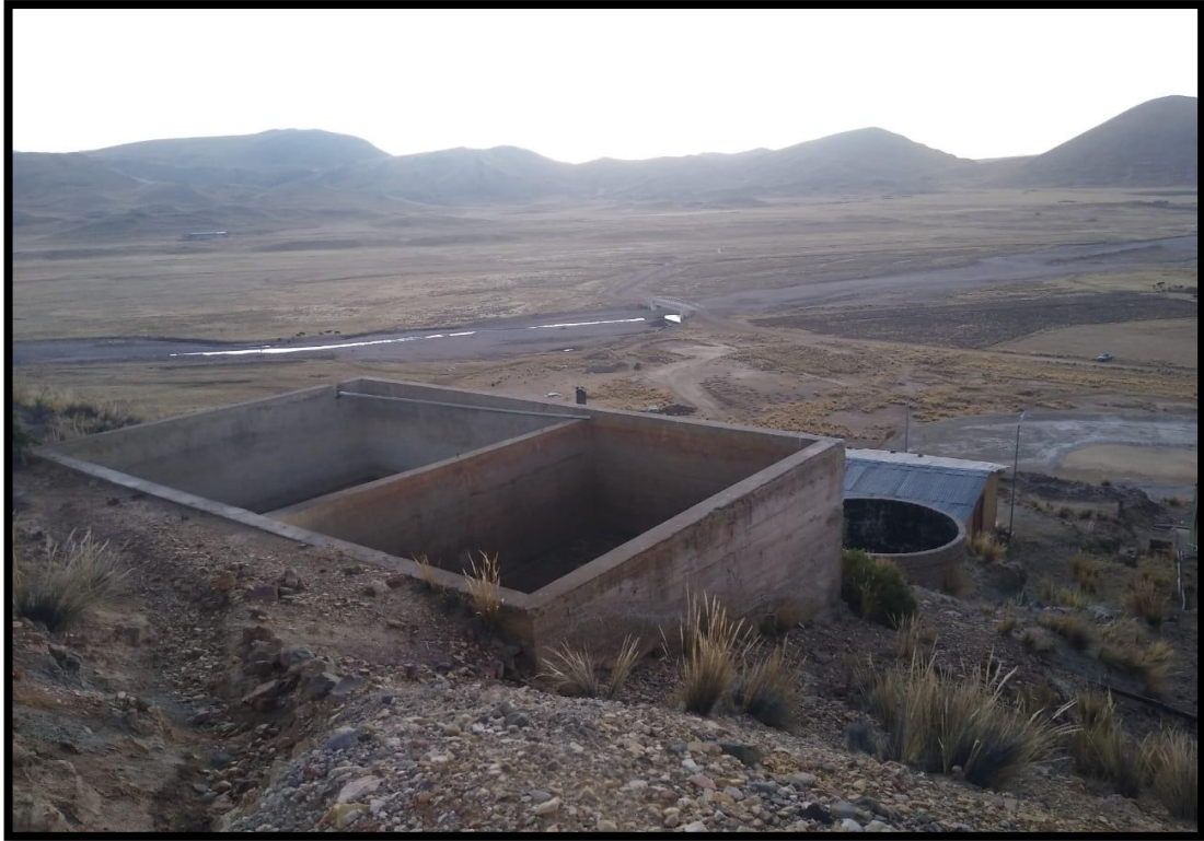
Figura A.5. Celdas de acondicionamiento de la planta concentradora de Tiquillaca
