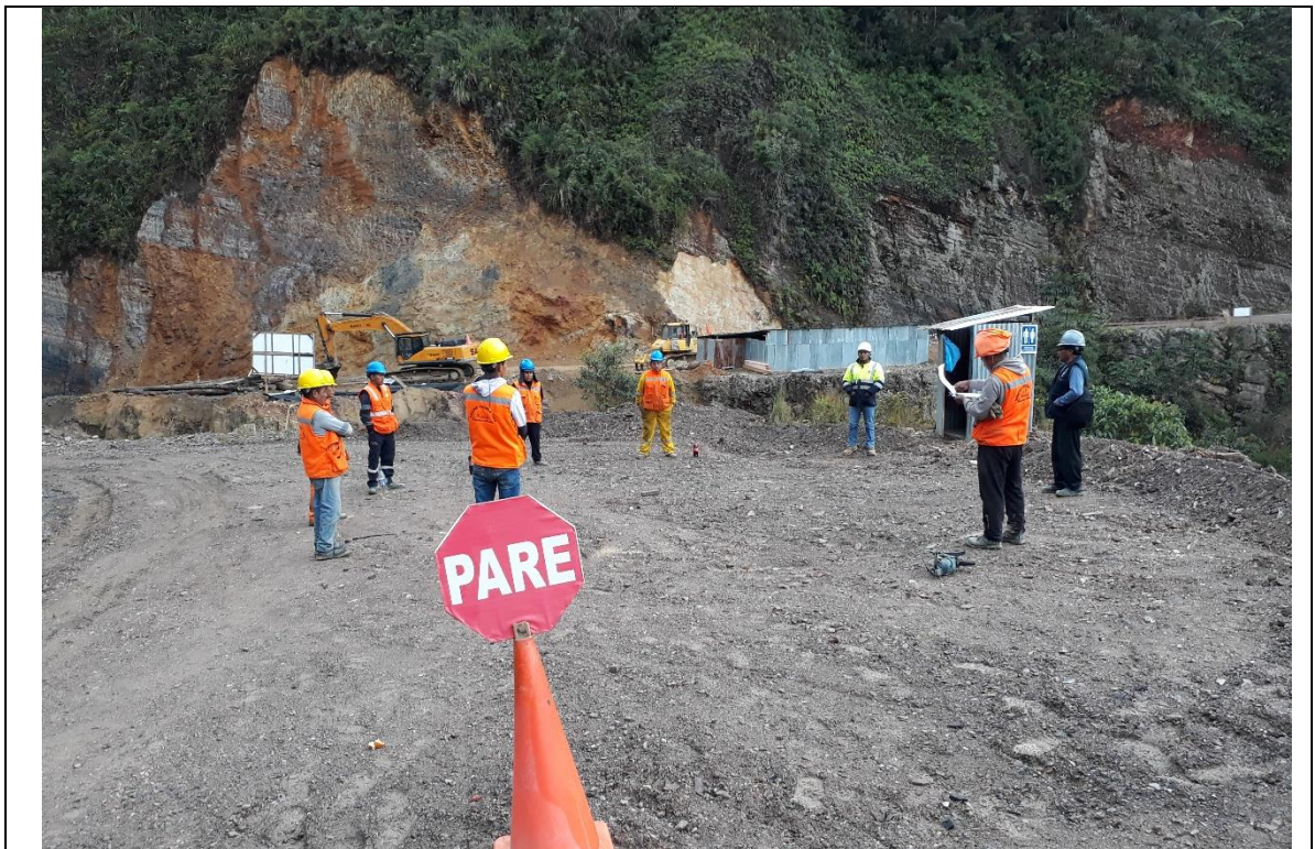
LA FOTOGRAFÍA MUESTRA: INDUCCION Y CAPACITACION AL PERSONAL DE OBRA DEL PUENTE CCAHUANACO.
