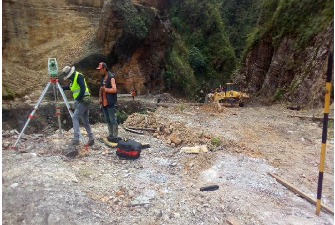
LA FOTOGRAFÍA MUESTRA: SE OBSERVA EL REPLANTEO INICIAL DEL PROYECTO Y UBICACIÓN DE LOS PUNTOS DE CONTROL.
