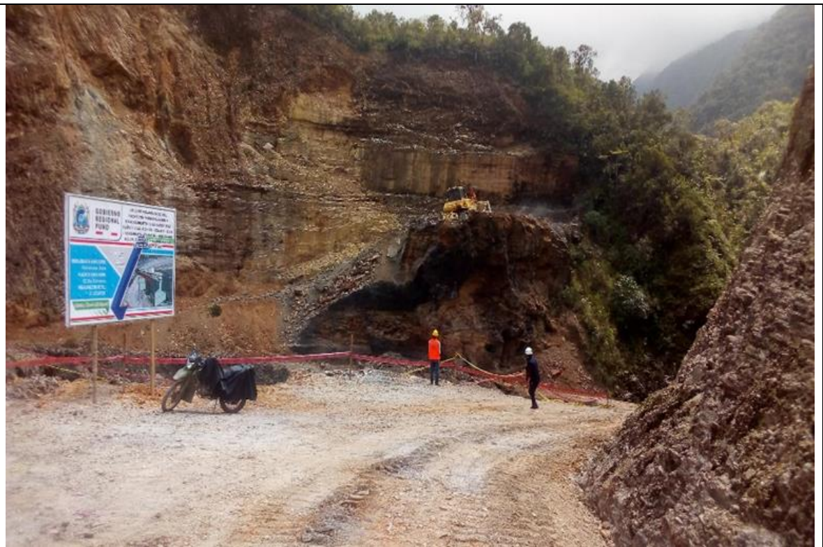
LA FOTOGRAFÍA MUESTRA: SE COLOCA LA CINTA DE SEGURIDAD EN LOS TRABAJOS DE CORTE INICIAL DE TALUDES EN ROCA SUELTA CON LA MAQUINARIA.
