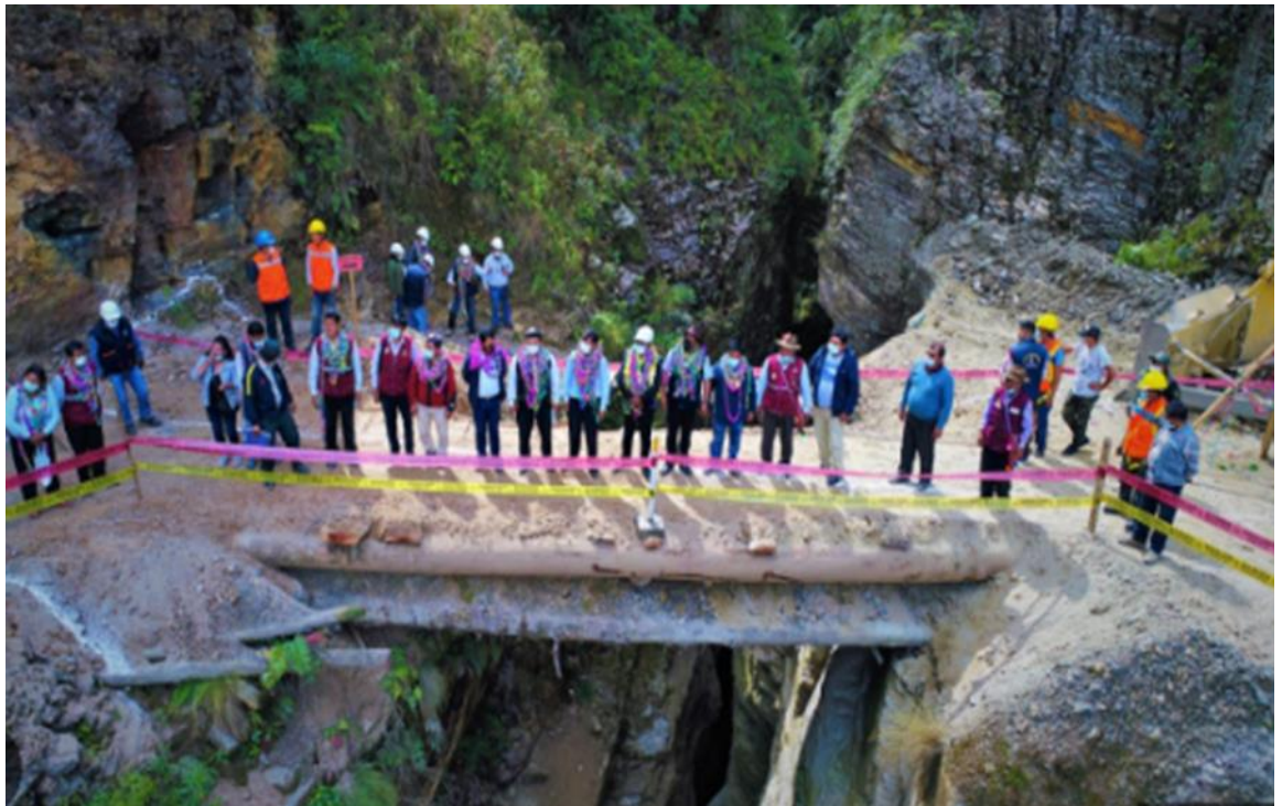
LA FOTOGRAFÍA MUESTRA: COLOCACION DE PRIMERA PIEDRA EN LA CONSTRUCCION DE PUENTE CCAHUANACO YANAHUAYA CON LOS AUTORIDADES DE LA REGION Y LOCAL Y LOS RESPECTIVOS BENEFICIARIOS.
