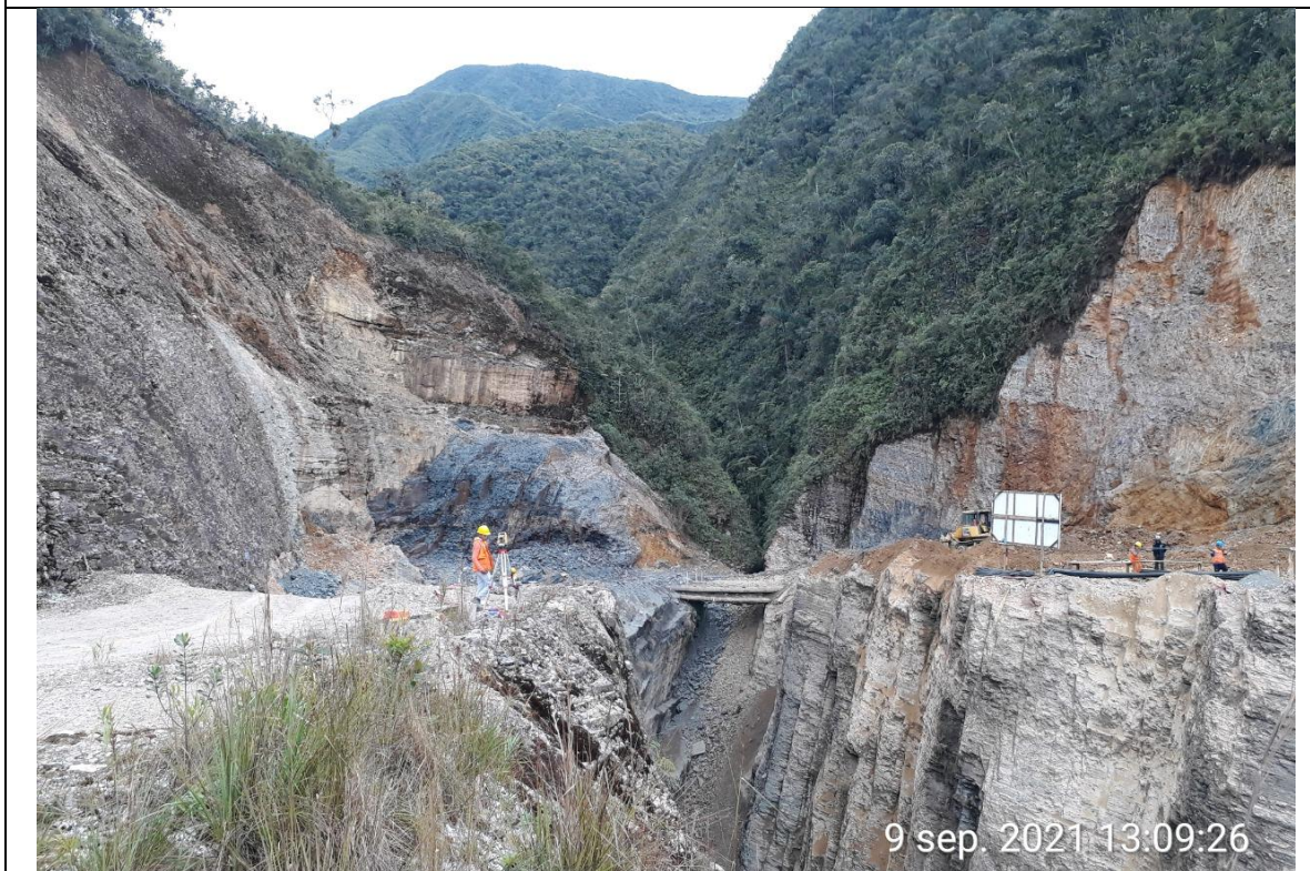
LA FOTOGRAFÍA MUESTRA: VISTA PANORAMICO DE LA OBRA DEL PUENTE CCAHUANACO
