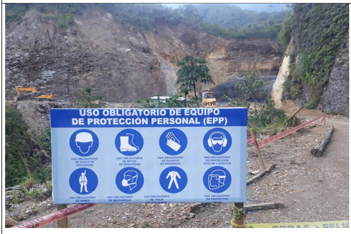
LA FOTOGRAFÍA MUESTRA: EL CARTEL DE IOBLIGACION DE EEP DE SEGURIDAD EN LA OBRA DEL PUENTE CCAHUANACO.
