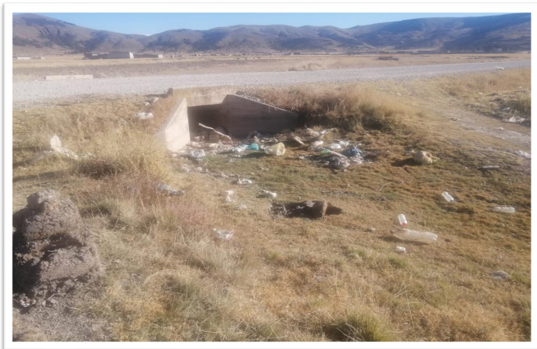
Imagen 18. Los residuos sólidos son arrojados debajo de los puentes en el Centro Poblado de Caritamaya
