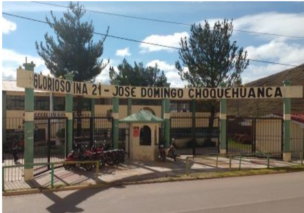
FOTOGRAFÍA N° 05: Institución Educativa Secundaria INA- 21 José Domingo Choquehuanca
