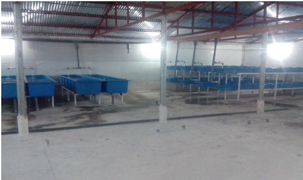
Figura 27. Instalaciones de la sala “A” Colque Accoyani, Distrito de Pucara, abril – junio del 2017.
