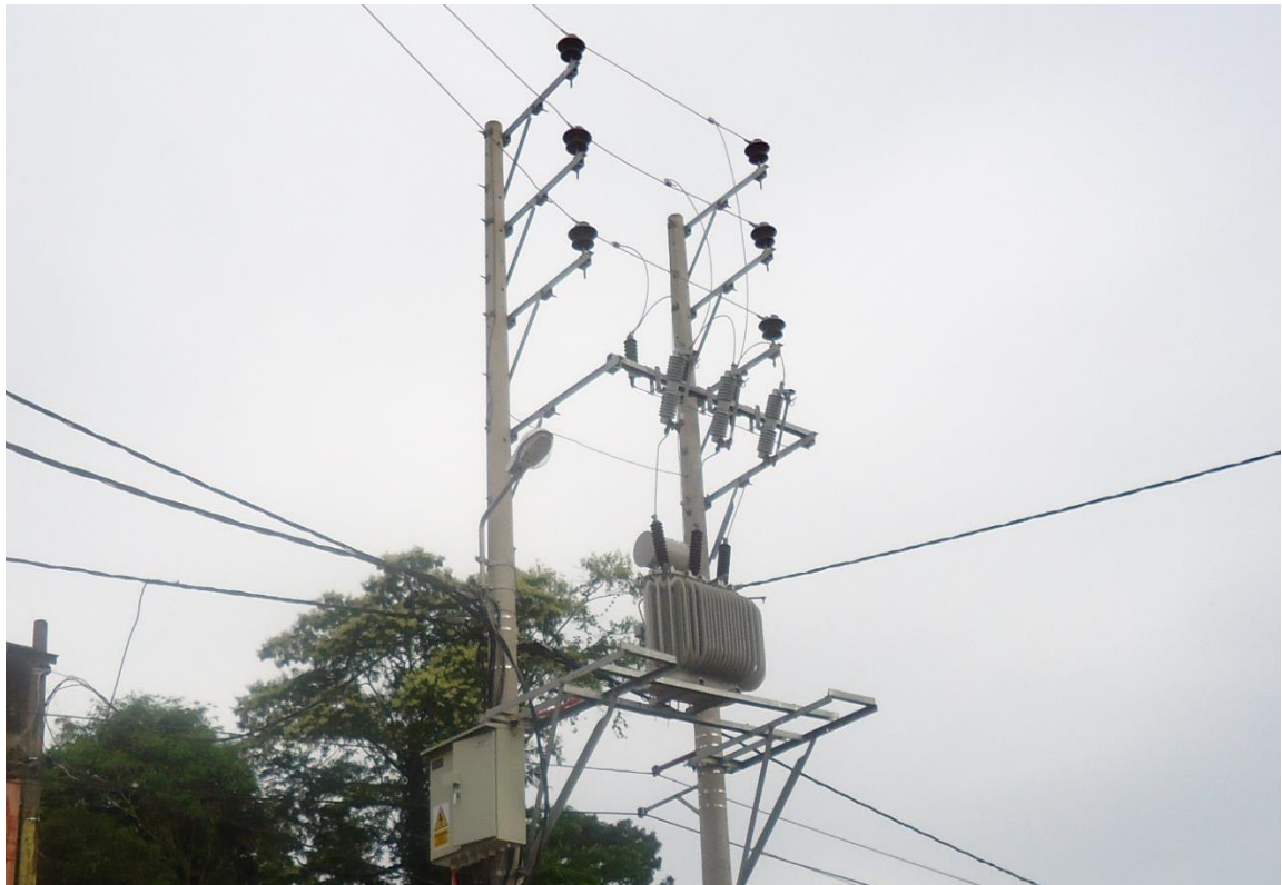
Figura 7: Sistema de protección Sub Estación de distribución
