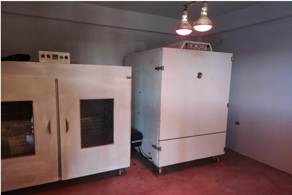
Figura 7. Acondicionamiento de la planta incubadora
