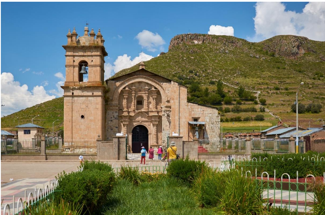
Figura 2. Iglesia del distrito de Vilque
