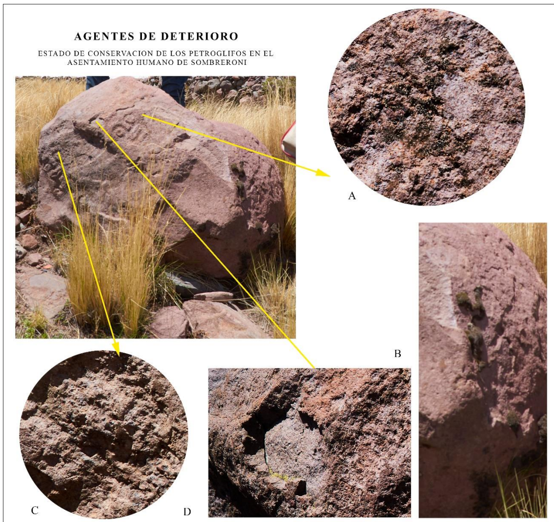
Figura 96. Agentes de deterioro, emplazamiento de Sombregoni
