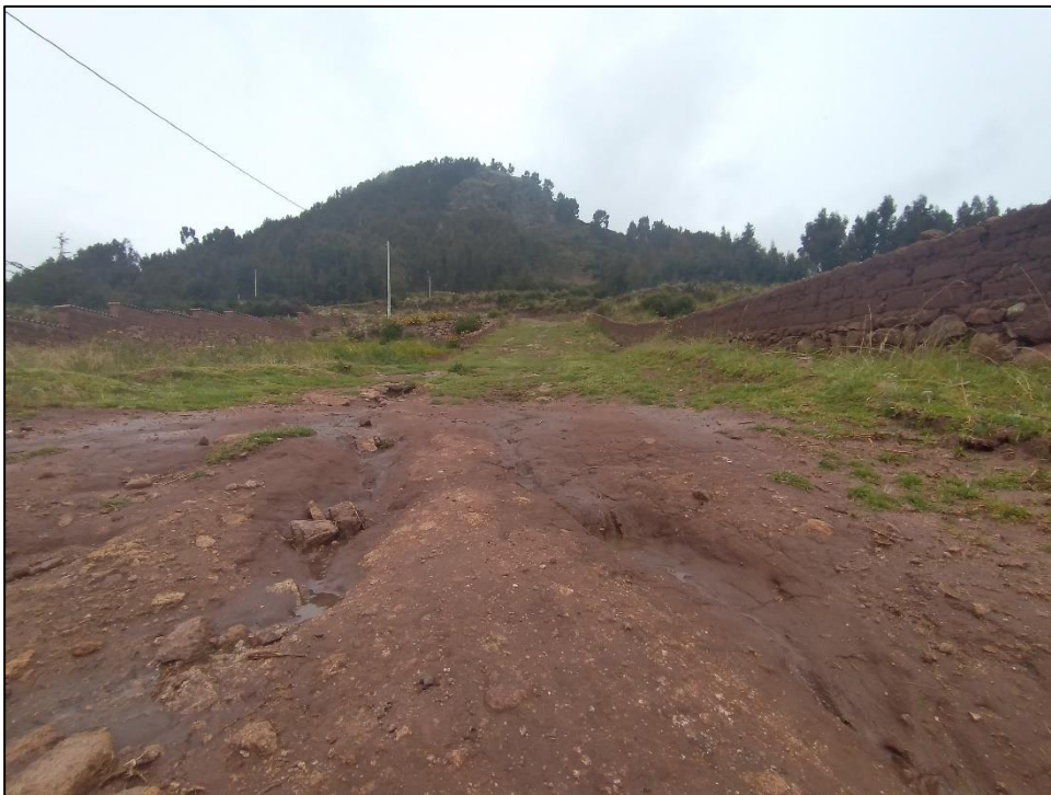
Fotografía 07. Erosión del suelo debido a las precipitaciones.
