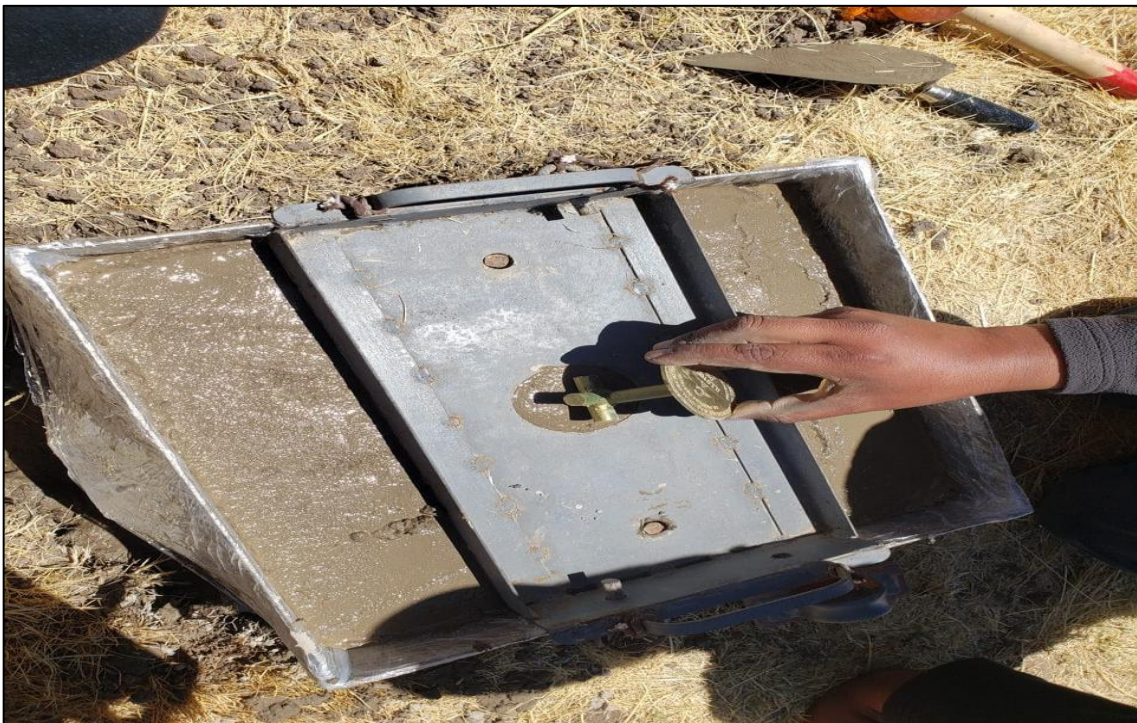
Fotografía 2. Colocado de la placa en el bloque de concreto.
