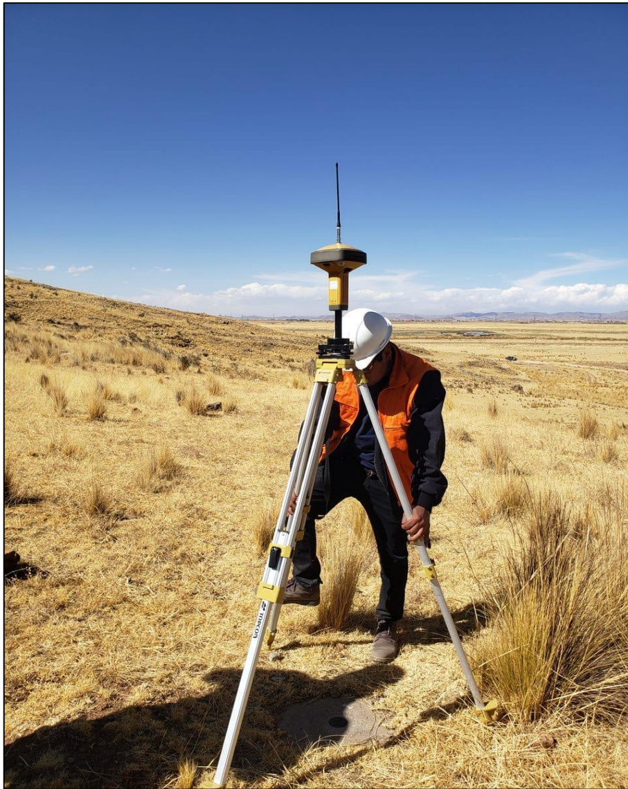
Fotografía 9. Instalación del equipo topográfico.
