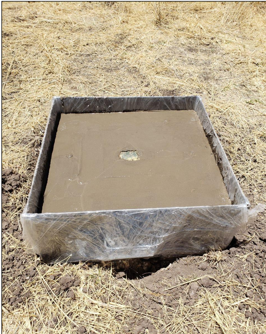
Fotografía 7. Curado del concreto vaciado.
