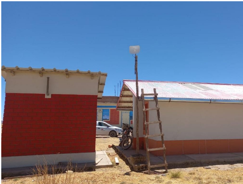
Primer equipo instalado antena de internet inalámbrica marca Ubiquiti, modelo
