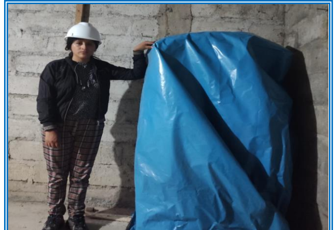
IMAGEN 02: ALMACENAMIENTO DEL CEMENTO CON PROTECCIÓN DE POLIETILENO, EN EL DISTRITO DE SAN GABAN. KM 314+325
