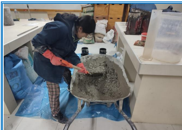
IMAGEN 51: ELABORACIÓN DE PROBETAS DE CONCRETO - MEZCLADO A MANO NTP 339.183
