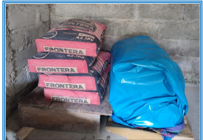
IMAGEN 04: ALMACENAMIENTO DEL CEMENTO, EN EL DISTRITO DE SAN GABAN. KM 314+325
