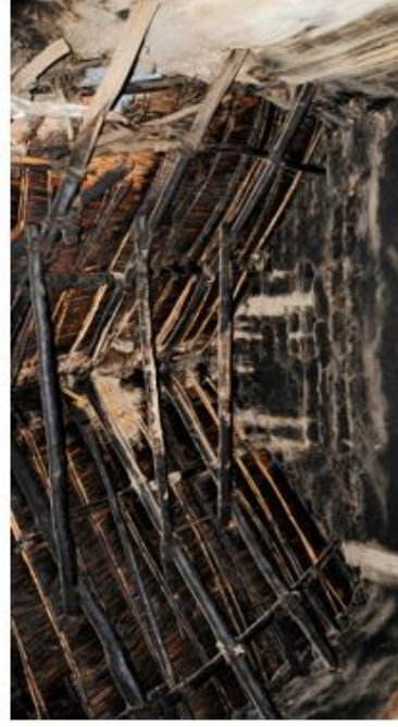
Imagen de la armadura de cubierta. Ambiente 112
