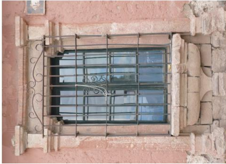
Reja en ventana principal. Sector A1
