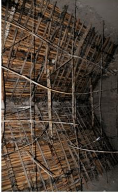
Imagen de la armadura de cubierta. Ambiente 201
