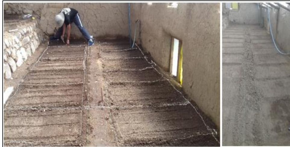
Figura 3: Acondicionamiento del invernadero C.E. Camicani
