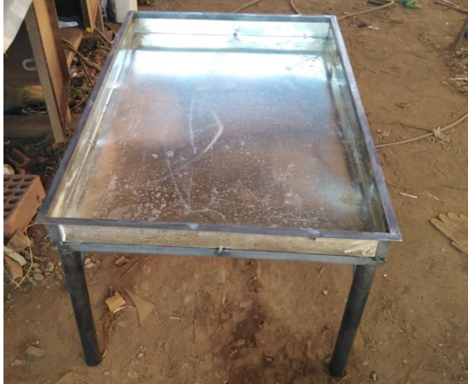
Fotografía 1: Armado de las estructura que soportara el prototipo.
