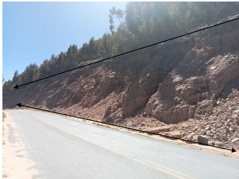
Figura 11. Deposito coluvial es grano medio a fino (grano 0.25 mm) de areniscas cuarzosas con presencia de poco limo.
