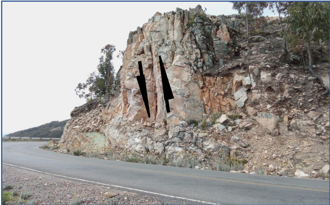
Figura 7. Falla inversa tiene Azimut/buzamiento 1/82SE. Km 55+700 se ubica en las coordenadas N 8295888 E 446486
