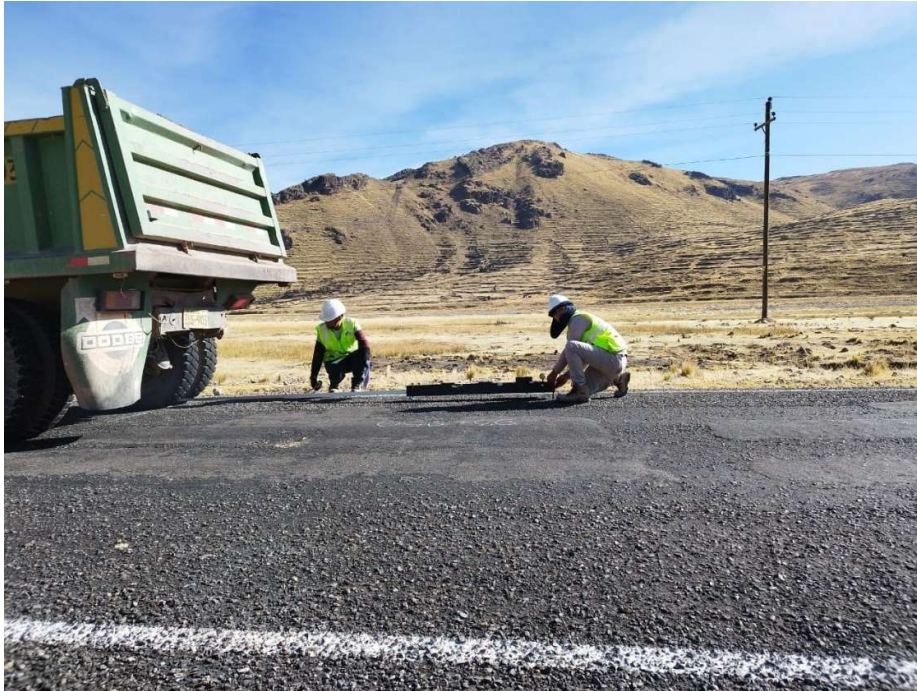
Fotografía N ° 17. Colocado de la Viga Benkelman entre las llantas del eje posterior.
