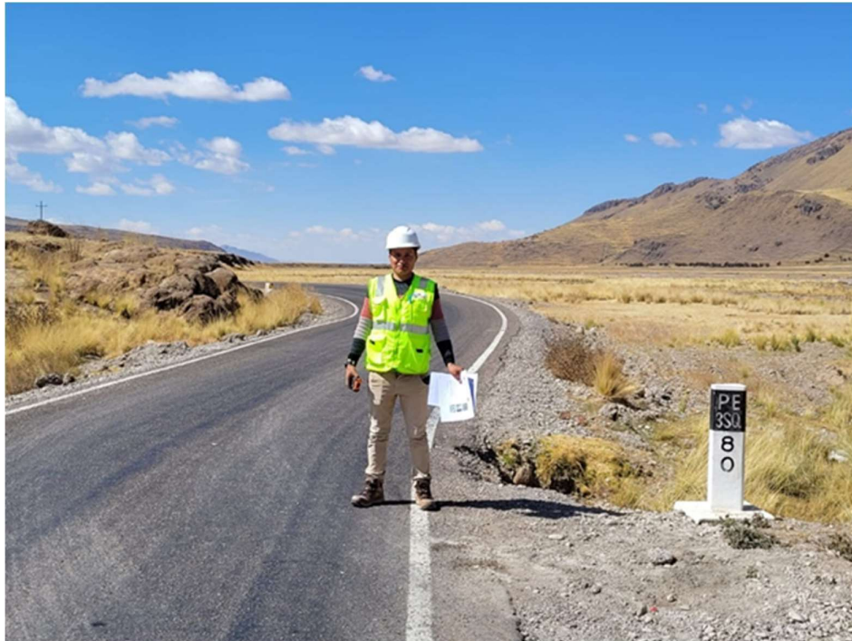
Fotografía N ° 01. Vía Palca – Lampa progresiva: Km 80+000.
