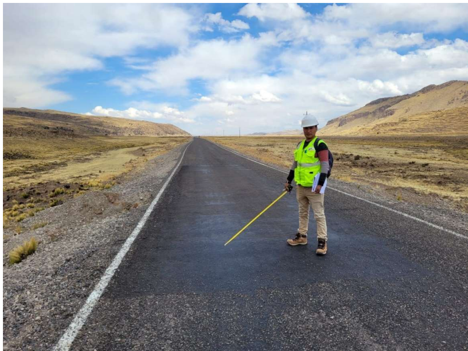
Fotografía N ° 06. Falla tipo 02 exudación de severidad baja del método del PCI.
