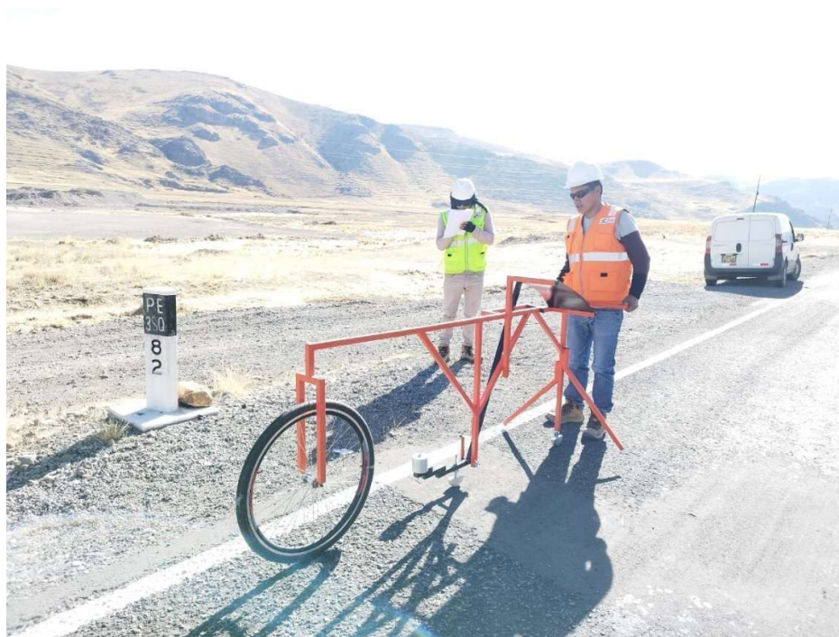
Fotografía N ° 12. Operación del rugosímetro Merlin y apunte de los resultados.
