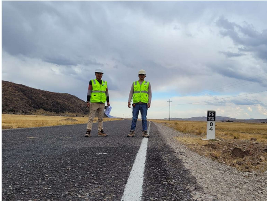
Fotografía N ° 03. Vía Palca – Lampa progresiva: Km 84+000.
