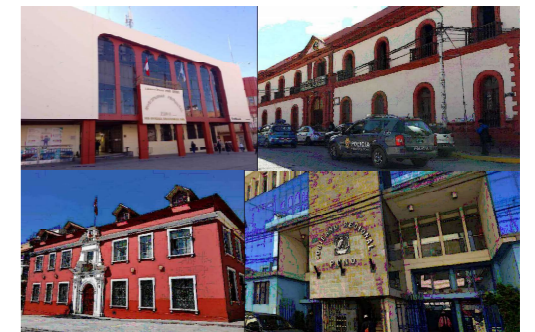
EQUIPAMIENTO INST. PUBLICO
