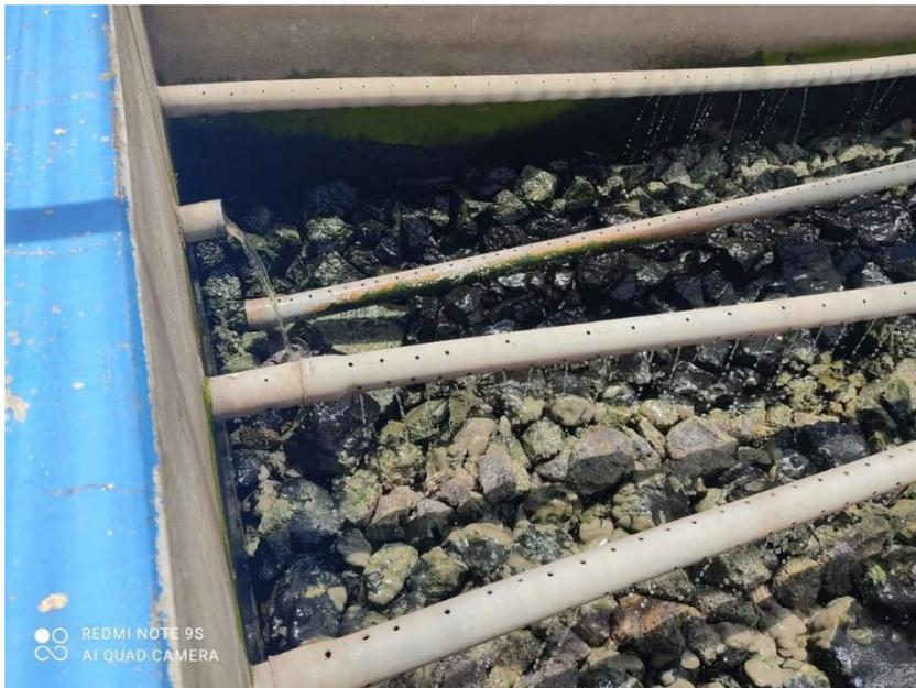
Nota: Se evidencia la falta de mantenimiento y refacción en la PTAR.
