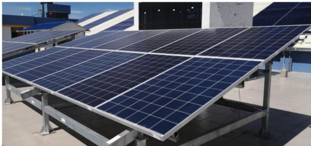
Figura 19. Vista parcial de los paneles instalados.
