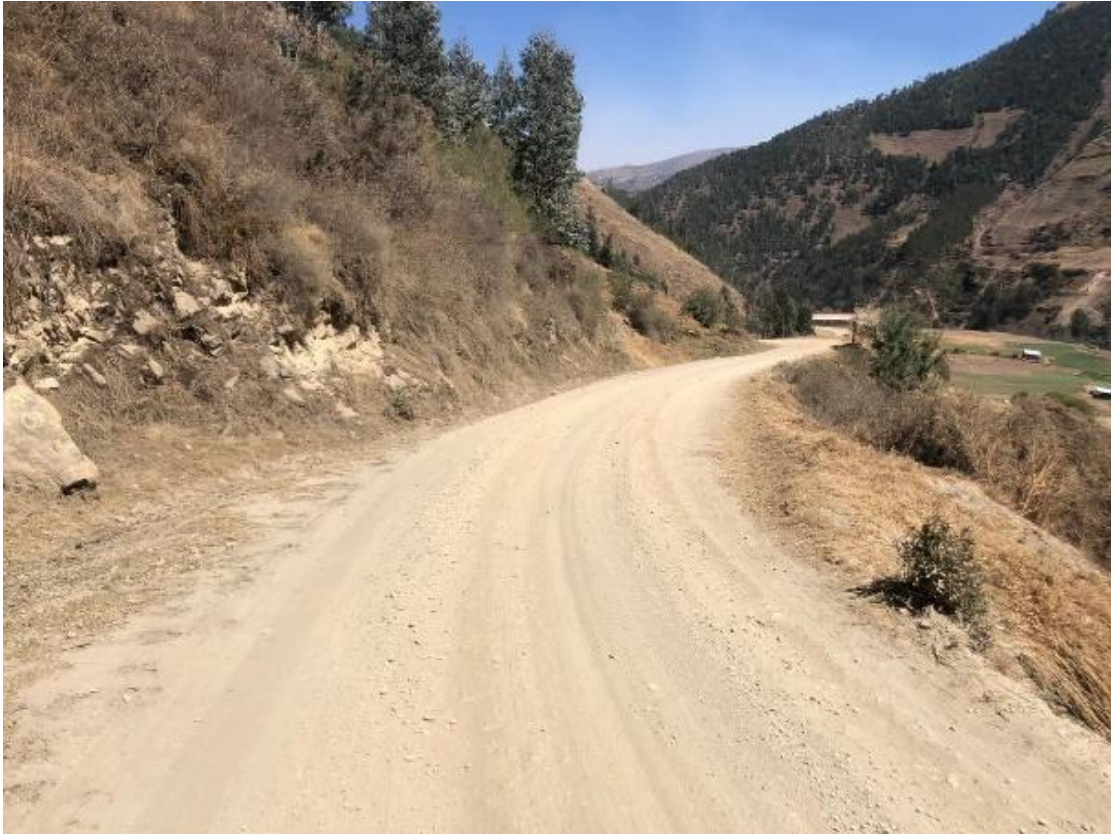
Figura 8. Superficie de rodadura existente tramo 4
