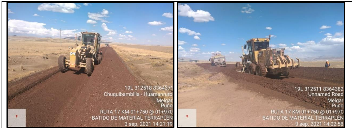
FOTOGRAFÍA 7 Y 8: Proceso de batido de material de terraplén en plataforma del km.01+750 al km 02+250.
