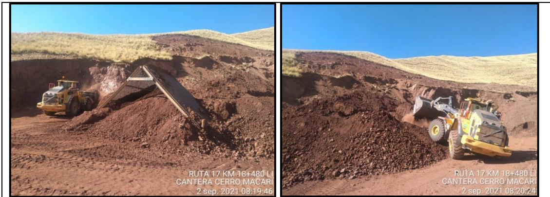
FOTOGRAFÍAS 1 Y 2: Proceso de producción de agregado en cantera Cerro Macarí zarandeando material para terraplén.
