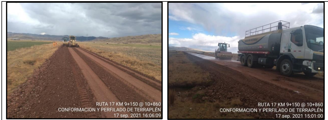
FOTOGRAFÍA 13 Y 14: Proceso de conformación y compactación de la capa terraplén del km. 09+150 al km. 10+950.
