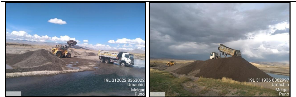
FOTOGRAFÍA 3 Y 4: Proceso de acumulación de agregado en la cantera Río Macarí para terraplén.
