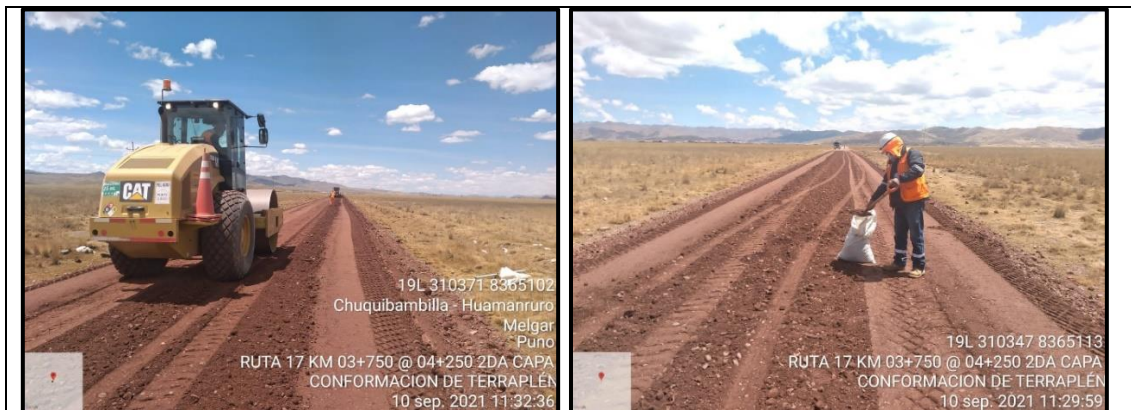
FOTOGRAFÍA 09 Y 10: A la izquierda se observa el proceso de compactación de terraplén del km 03+750 al 04+250. A la derecha se observa muestreo de material para envío a laboratorio.
