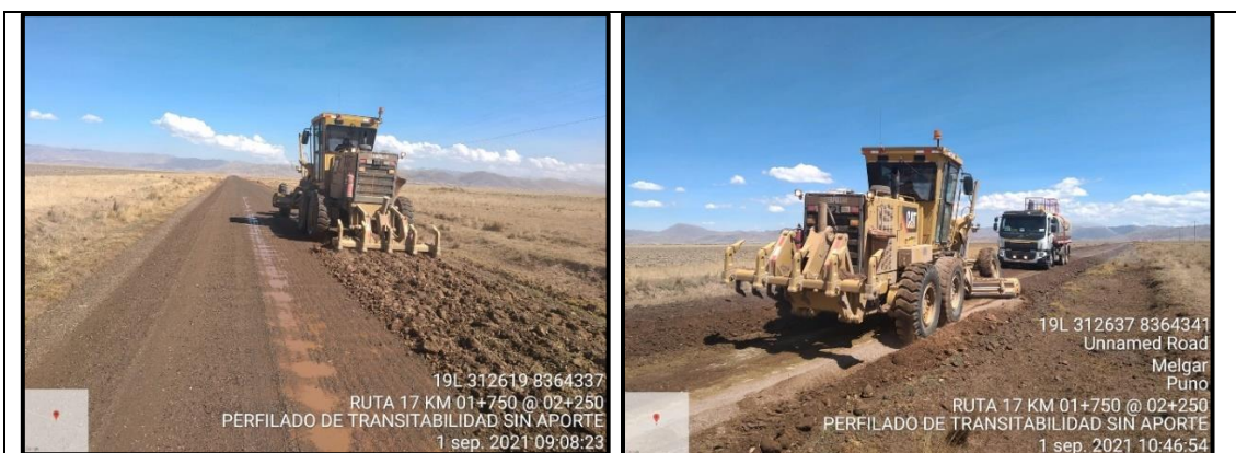
FOTOGRAFÍA 5 Y 6: Proceso de perfilado sin aporte de material previo a la colocación de la capa de terraplén. A la izquierda, nótese los baches en la plataforma existente que evidencian fallos a nivel de subsuelo.
