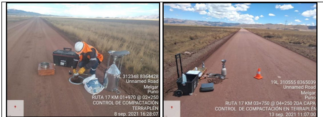
FOTOGRAFÍA 15 Y 16: Controles de compactación en capa de terraplén por método cono de arena en el km. 02+000 y km. 04+000 respectivamente, esto se realiza cada 100 metros lineales y para cada capa con una compactación mínima de 95%.
