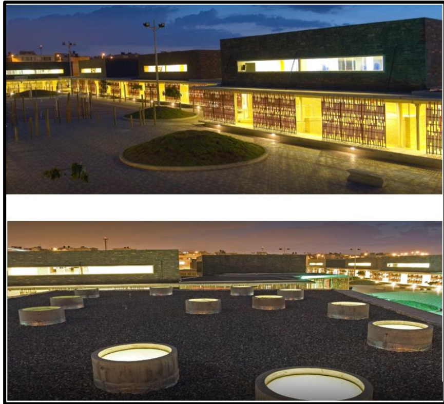
Figura 38: Aulas multiuso del Colegio GERARDO MOLINA
