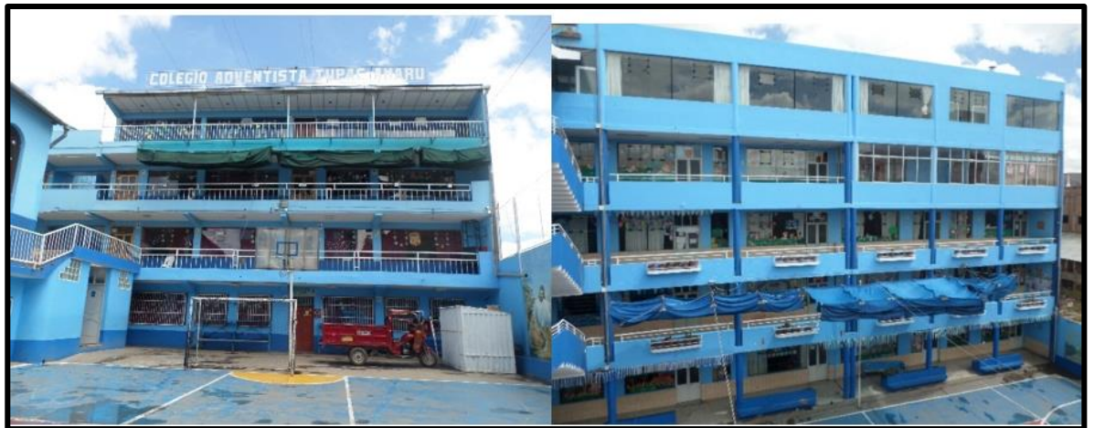
Figura 3: Patio y pabellón central CATA
