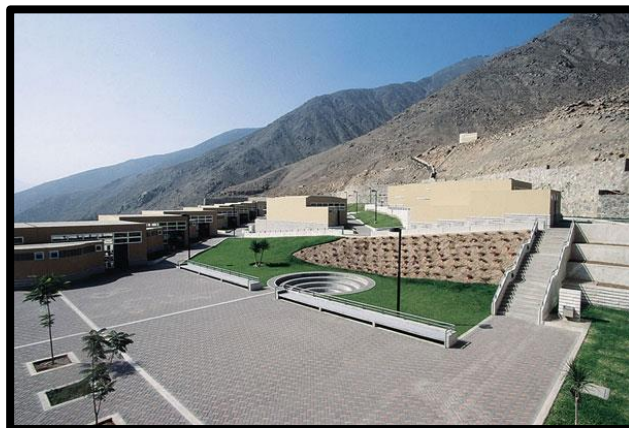
Figura 56: Vista del COLEGIO SAN PEDRO
