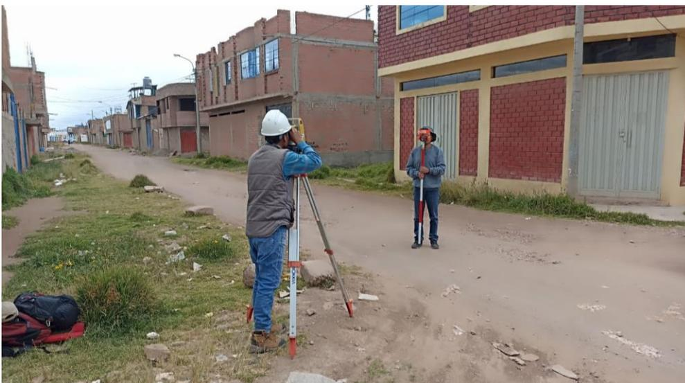
Nota: Se muestra en la figura la obtención de los puntos en el eje de la vía.
