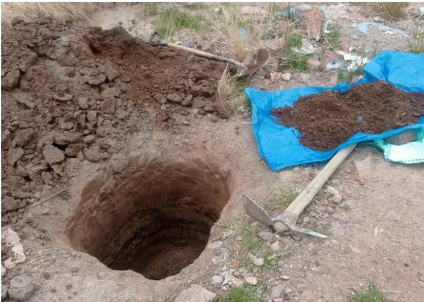
Nota: Se observa en la figura el cuarteo de material excavado para llevar el suelo más representativo.
