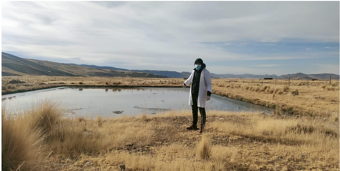
Figura 20. Vista panorámica de la planta de oxidación aguas residuales del distrito de Nuñoa
