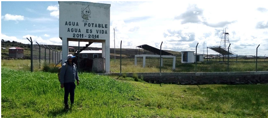
Figura 25. Vista del sistema de agua potable anterior
