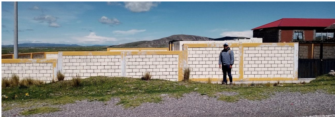
Figura 26. Vista de la ubicación del reservorio
