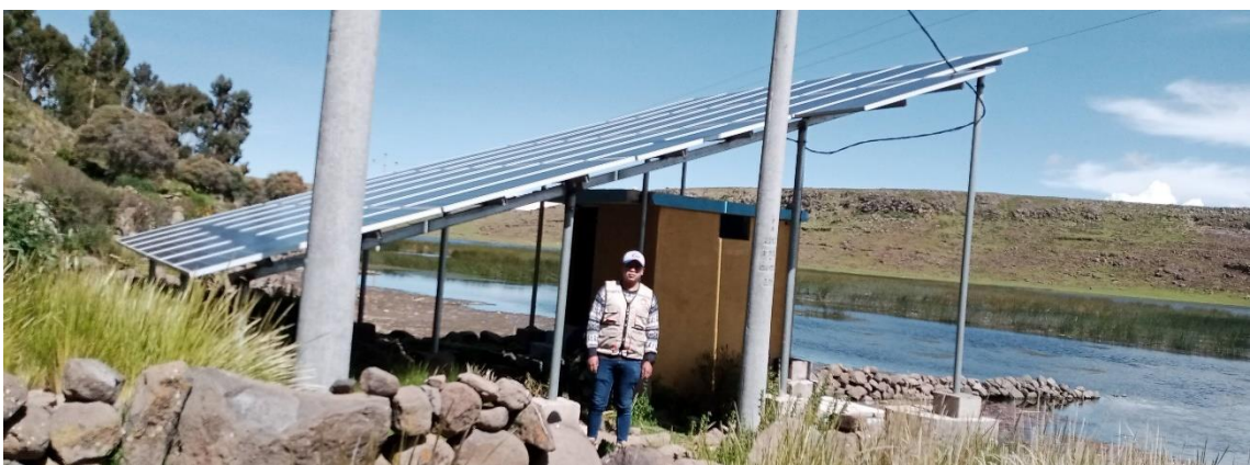
Figura 30. Vista de la caseta de bombeo
