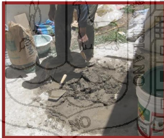
Foto 46 MEZCLA DE MORTERO
