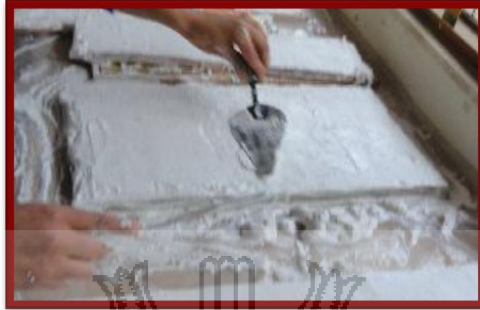
Foto 12 APLICACIÓN DEL REVESTIMIENTO 2: MORTERO
