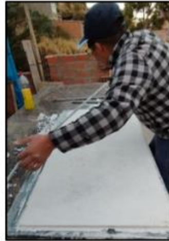
(e) Nivelado y regleado del vaceado
