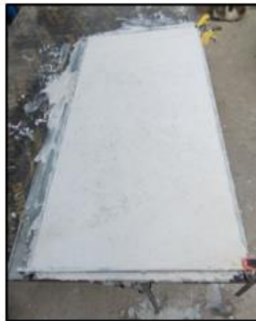
(f) Moldeo del panel termoaislante
