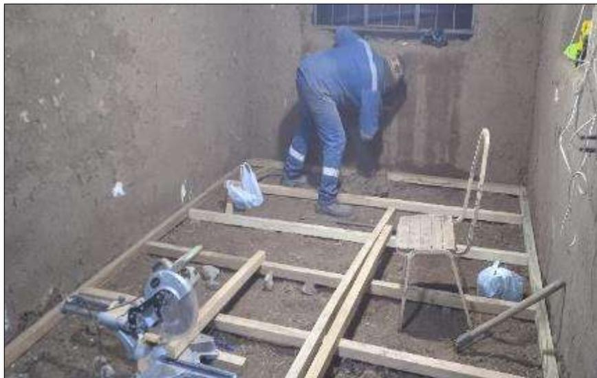
**FOTO 64.** VISTA DE ESTRUCTURA INTERNA CUARTONES DE 3"X 2" PARA INSTALACION DE PISO.
