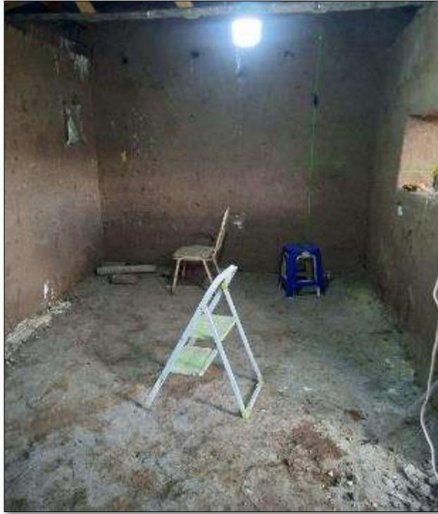
**FOTO 63.** VISTA DEL TRAZO PARA MODIFICACION DE MURO PARA NUEVA VENTANA.
