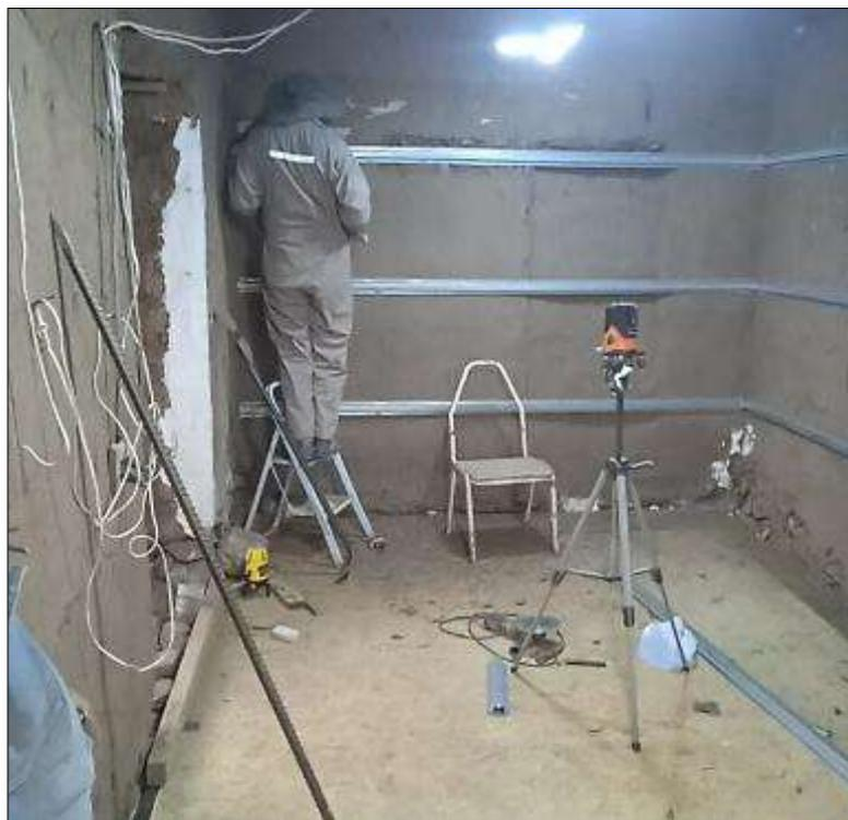
**FOTO 70.** VISTA DE LA INSTALACION DEL PERFIL GALVANIZADO OMEGA.
