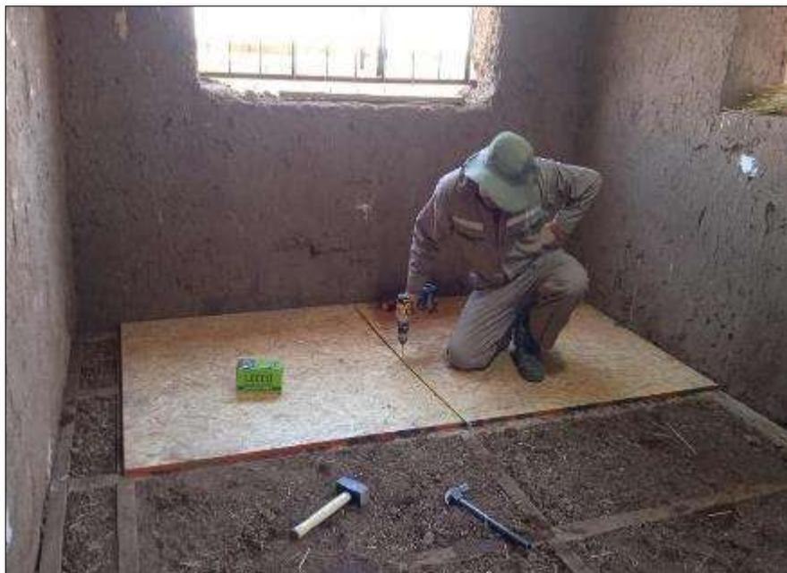
**FOTO 66.** VISTA DE INSTALACION DE PISO DE PLANCHAS DE OSB.
