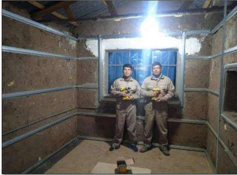
**FOTO 71.** VISTA DE LA CULMINACION DE INSTALACION DE LOS PERFILES OMEGA RECEPTORES DEL PANEL.
