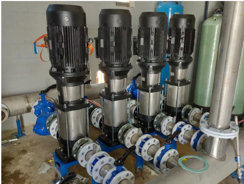
Figura 4: bomba centrífuga vertical.
