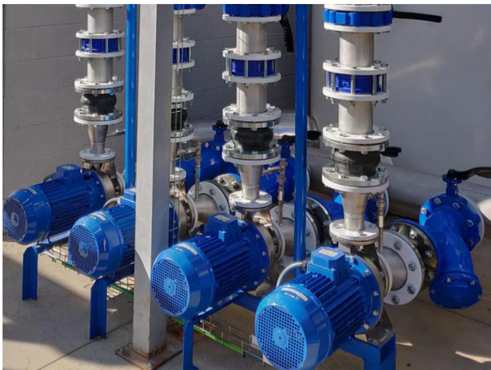
Figura 3: Bomba centrífuga horizontal.
