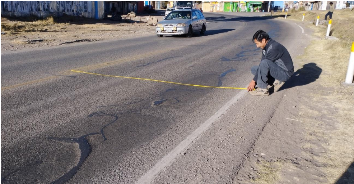
Fotografía 2. Medición de condiciones de infraestructura (ancho de carril, ancho de berma y pendiente) y control (zonas de no rebase) en la vía PE-3S (Puno – Juliaca)
