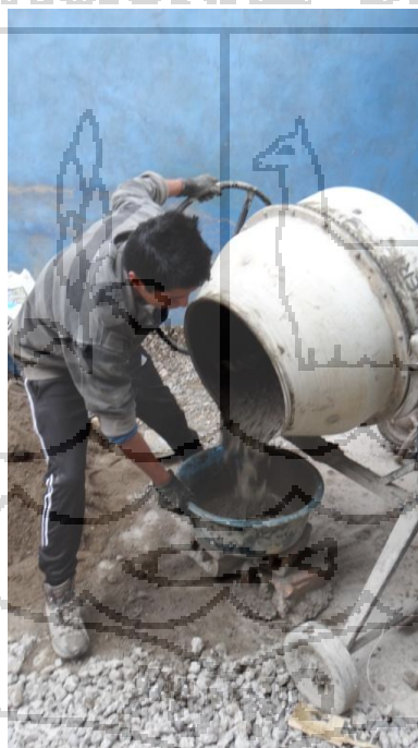
Fig. 5.48 Concreto recién mezclado.
