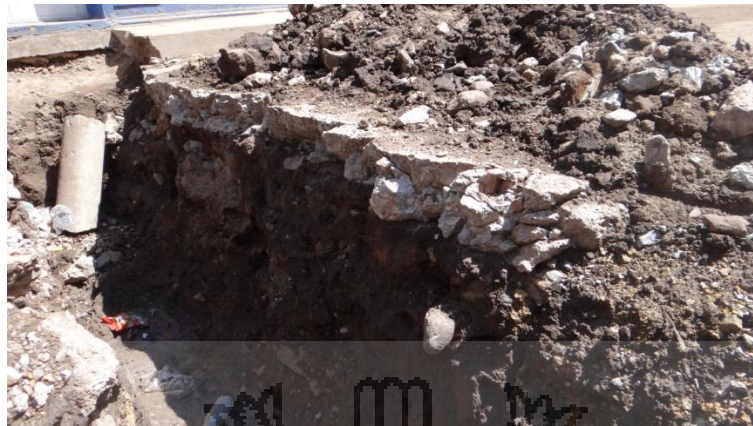
Fig. 5.4 Excavación para conexión domiciliaría.
