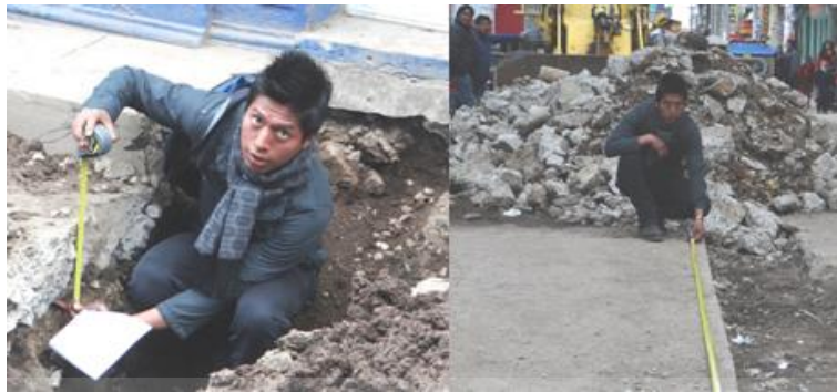
Fig. 5.9 Metrado del pavimento demolido
