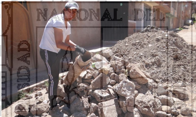
Fig. 5.10 Selección del material no utilizable
