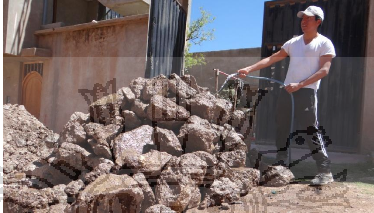
Fig. 5.12 Lavado del pavimento a utilizar
