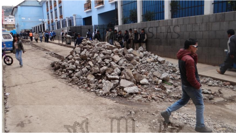
Fig. 5.6 Demolición del Jr. Fermin Arbulú.
