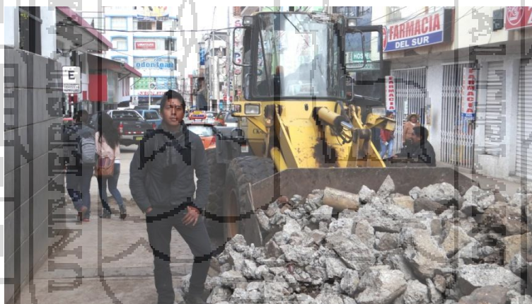
Fig. 5.8 Acopiado de pavimento demolido por el cargador
