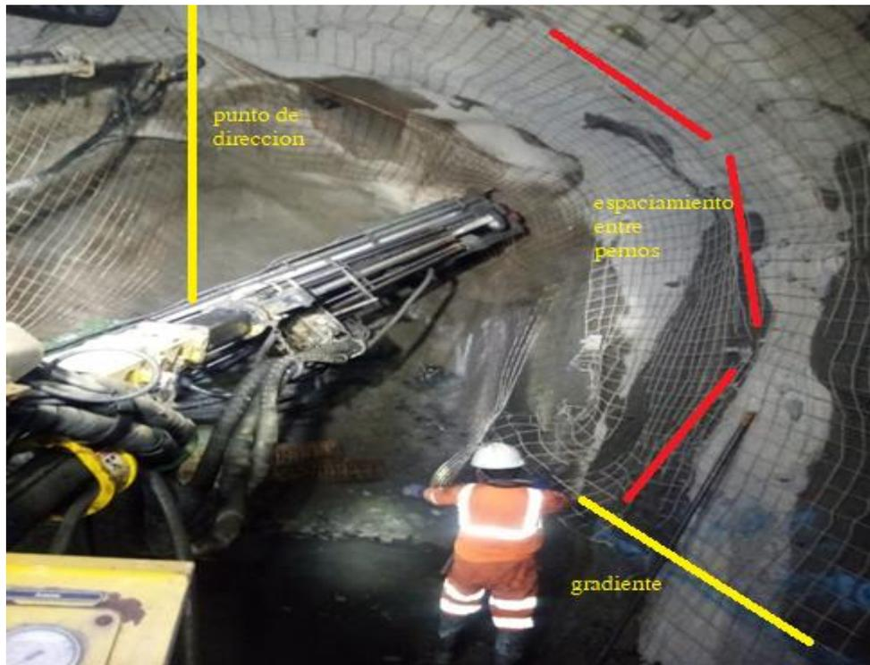
**Figura 7.** Presentación de malla y perno Omegabolt en la rampa 100
