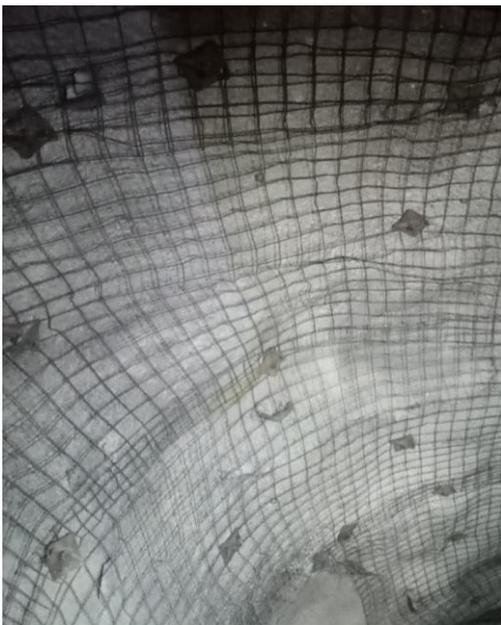
**Figura 1.** Espaciamiento en el techo para el perno Hydrabolt
