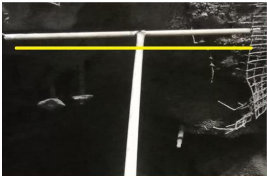
*Figura 6.* Plantilla para la distribución de pernos Omegabolt
