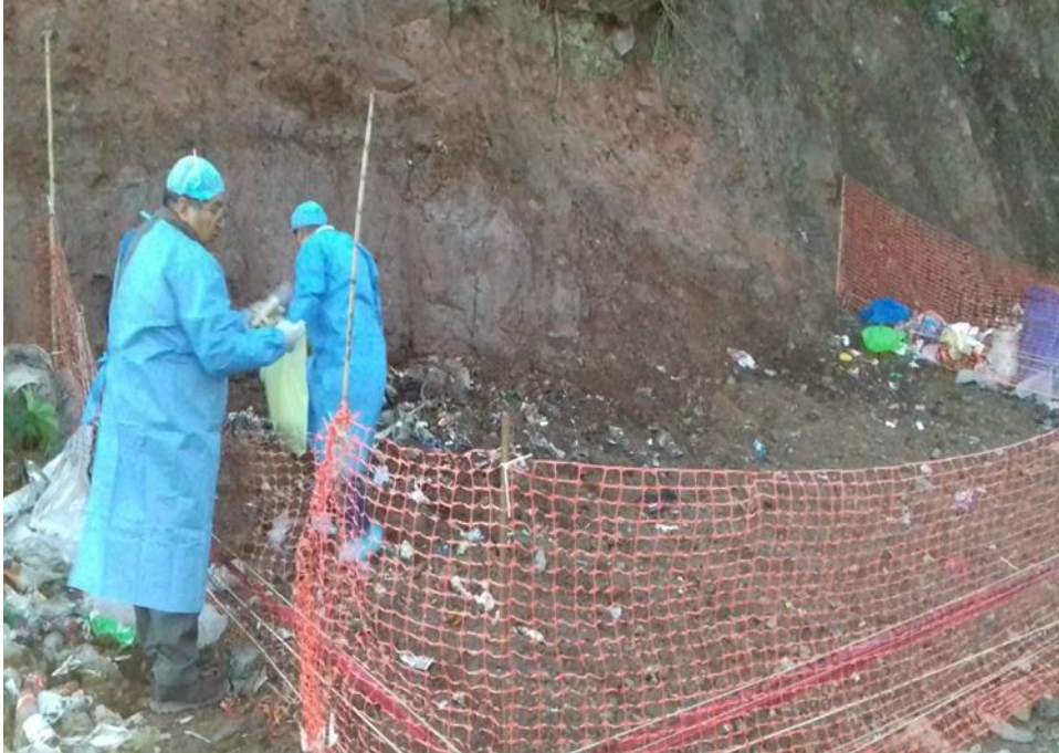
Figura 2. Suelo agrícola en el relleno sanitario Quitasol.
