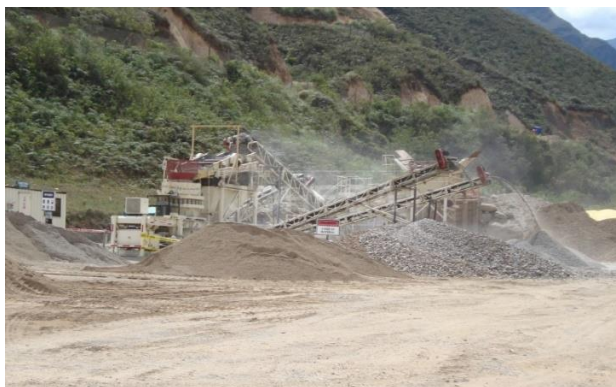
Figura 1. Cantera y planta chancadora, Morro Blanco, distrito de San Salvador (Agregado Grueso y Arena Chancada)
