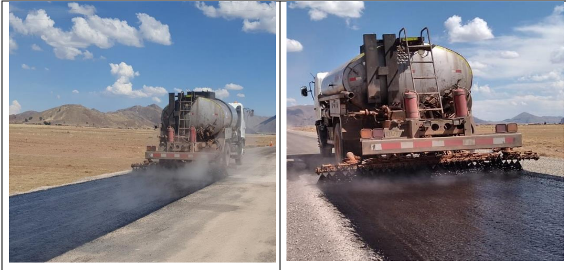
Figura 20. Proceso de esparcido de la emulsión asfáltica
