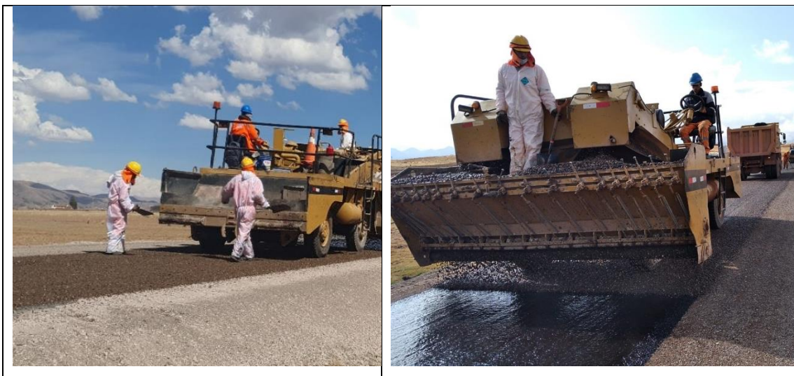
Figura 21. Proceso de esparcido del agregado
