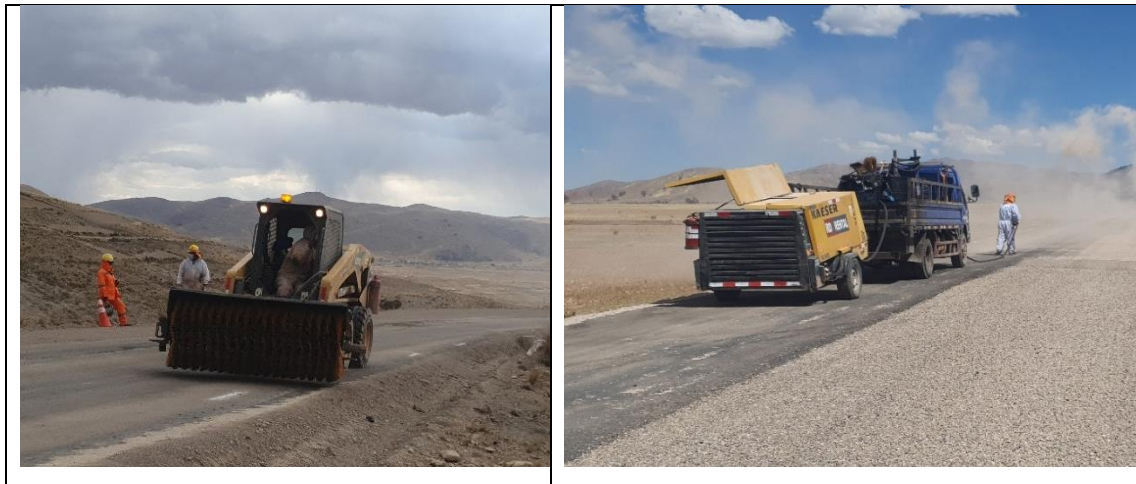
Figura 24. Proceso de limpieza final
