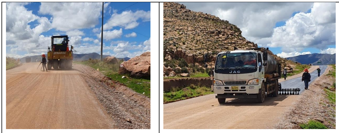
Figura 19. Proceso de imprimación de la técnica OTTA SEAL
