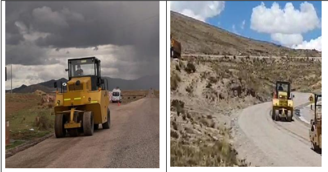
Figura 23. Pasado de rodillo neumático
