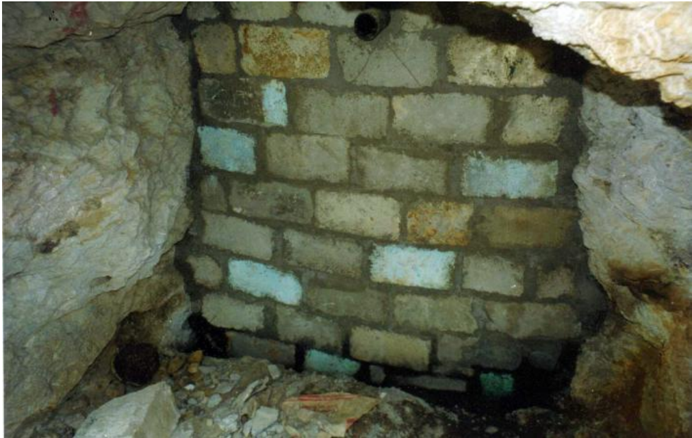
Figura 61. Clausura de galerías con bloqueta de concreto
