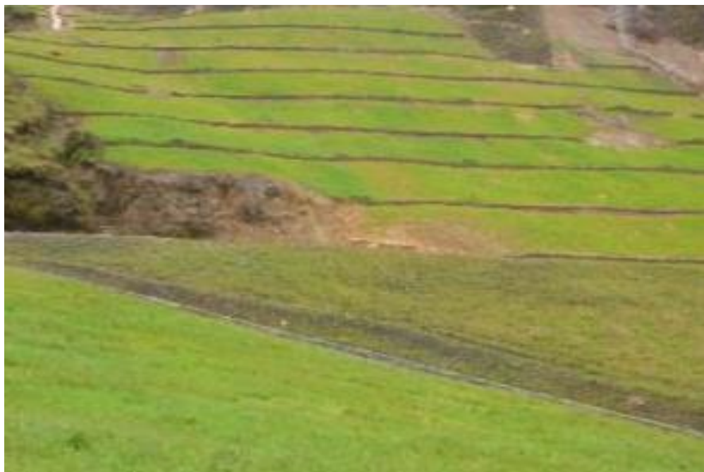
Figura 56. Laderas con muros para evitar la erosión de la remediación
