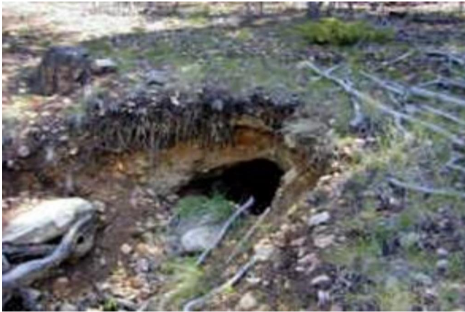
Figura 3. Galería colapsada
