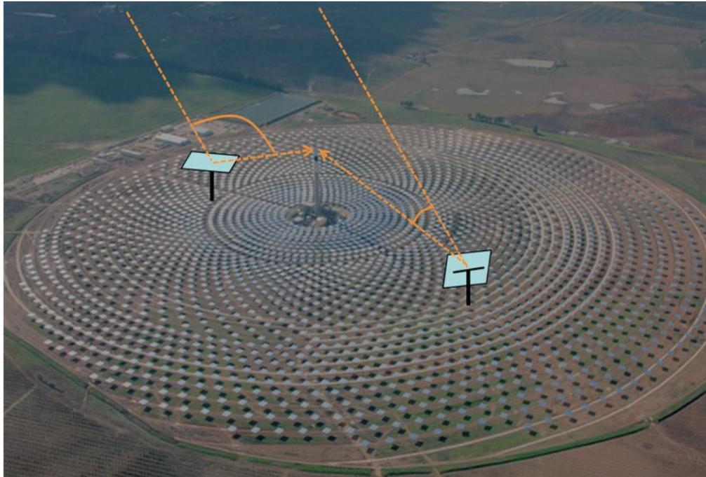
**Figura 36:** Inclinación y orientación de heliostatos situados a ambos lados de la torre.
