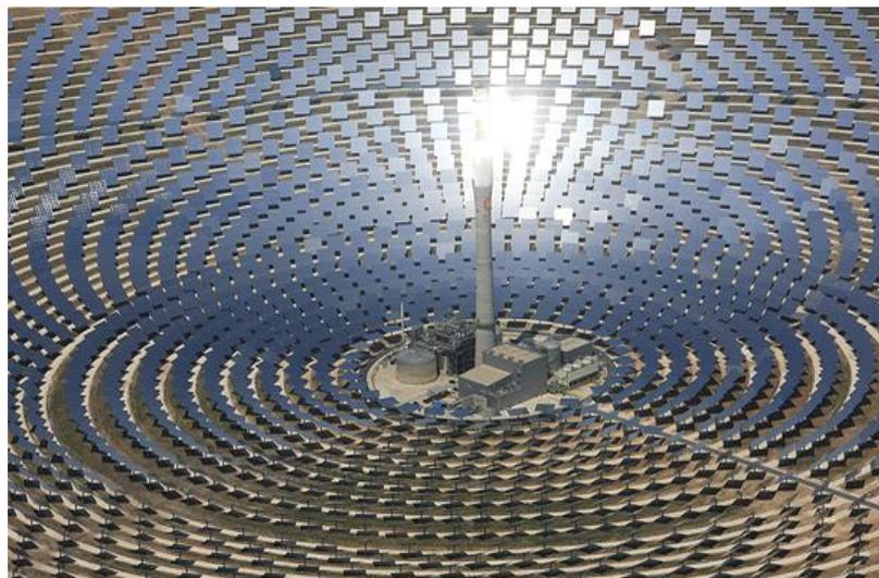
**Figura 19:** Tecnología de campos de heliostatos y torre receptora
