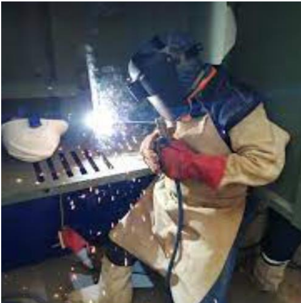
Figura 7. Soldadura por arco eléctrico con electrodo revestido
