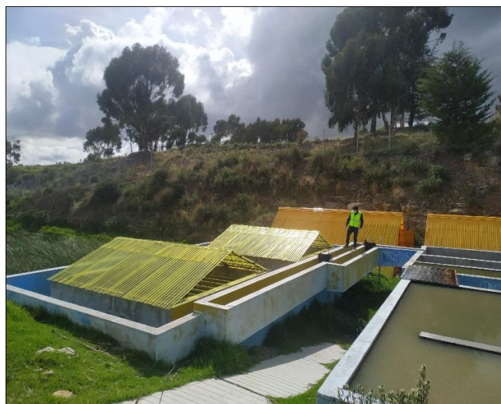
Filtros biológicos de la ptar Chucuito
