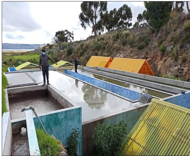
Sedimentadores de ptar Chucuito
