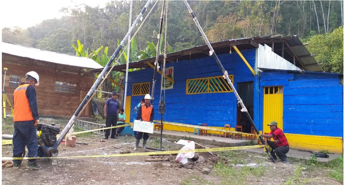
Figura 35 Ensayo de Penetración Estándar (SPT) Fuente: Equipo técnico.
