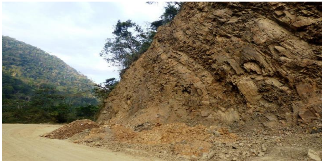
Figura 20 Formación Sandia conformado por pizarras y areniscas delgadas.
