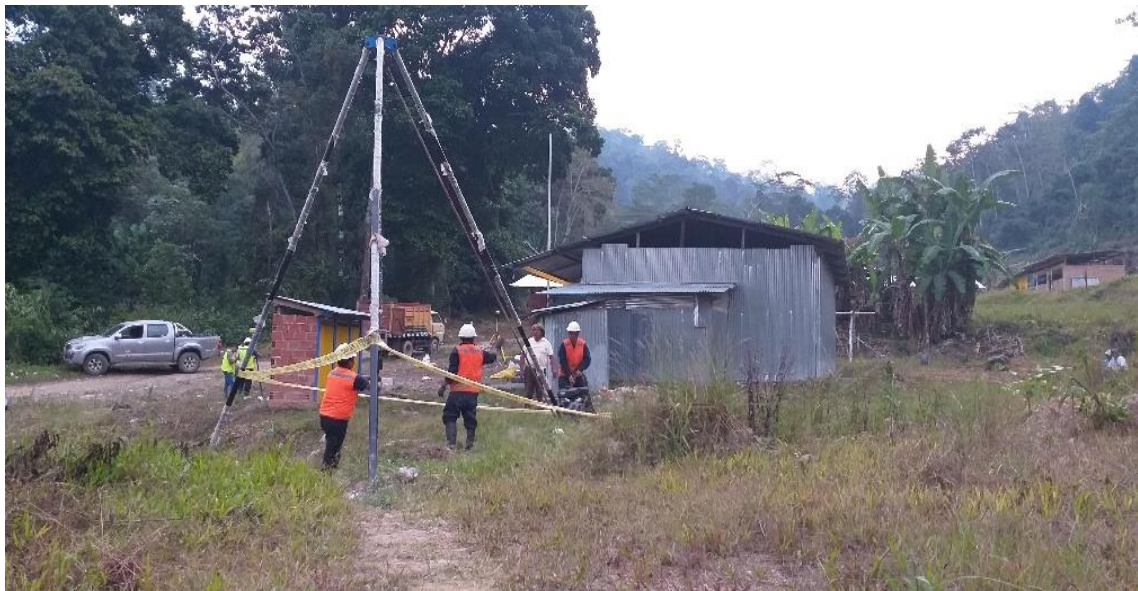
Figura 9 Instalando los equipos para los ensayos de campo.
